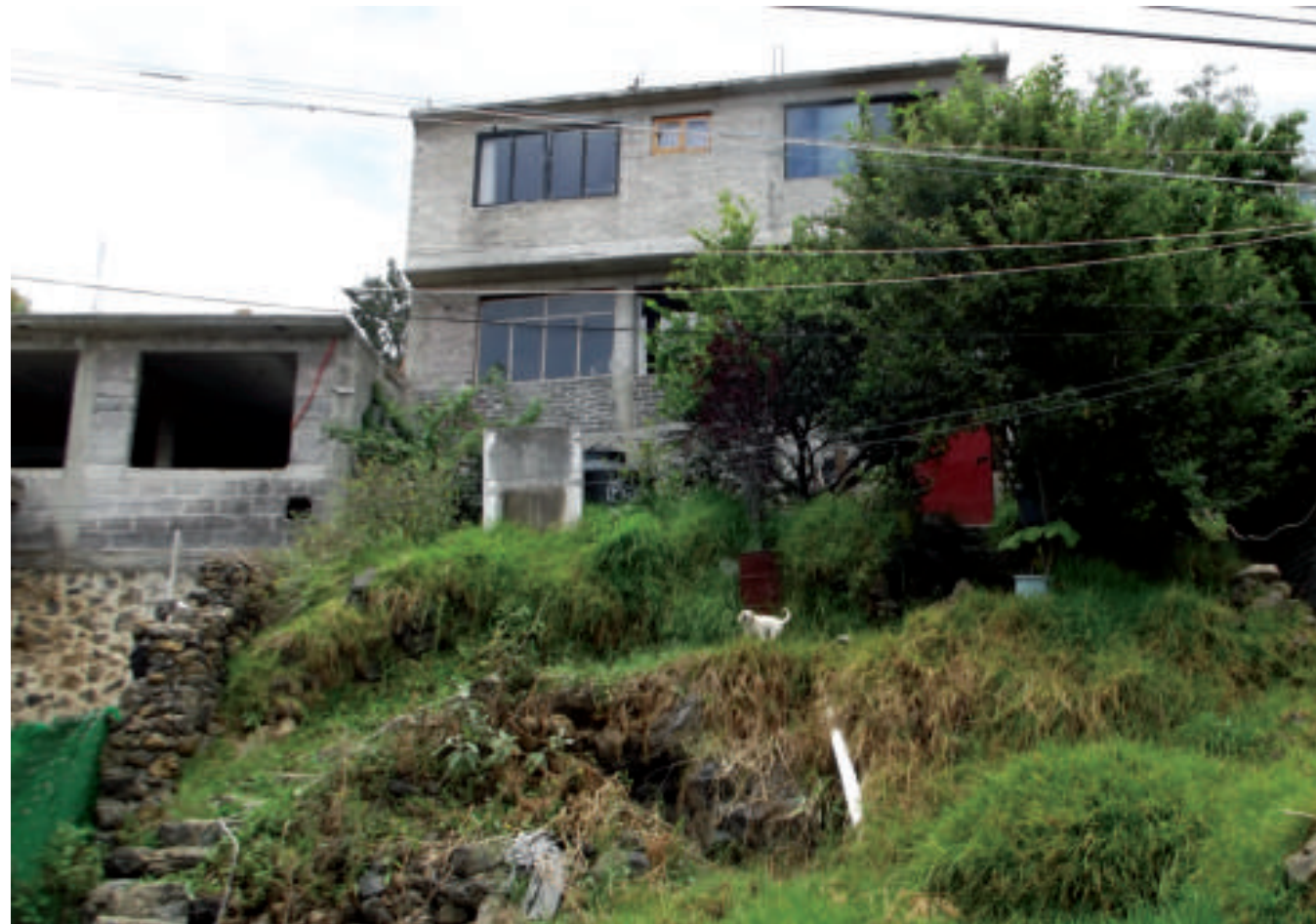
Figura 5.19. Fotografía C del polígono de peligro y vulnerabilidad. Peligro por derrumbe en Calixpa, San Andrés Ahuayucan (19.2201° N, 99.1048° W. Calle: sin nombre oficial).
