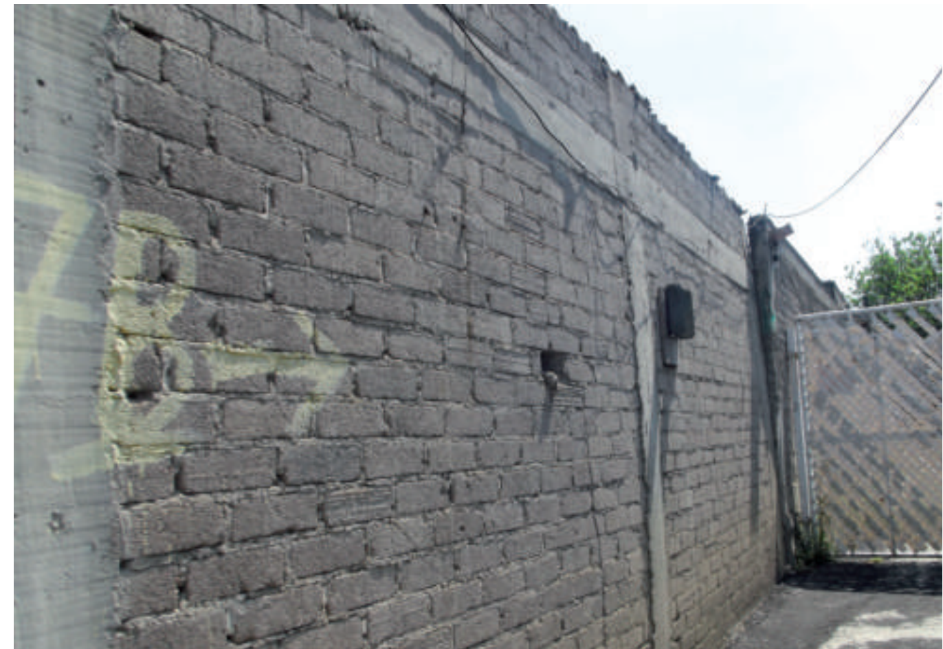
Figura 5.68. Fotografía C de la zona de riesgo. Separación lateral entre las bardas (19.2440° N, 99.0924° W. Calle: Miguel Hidalgo).
