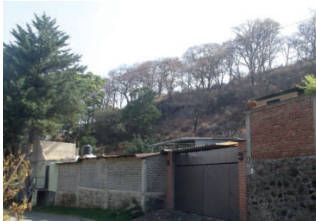
Figura 5.12. Fotografía A de los polígonos de peligro y vulnerabilidad. Muestra la vulnerabilidad de las viviendas expuestas a caída de roca en el Camino al cerro Tepetonco (19.2134° N, 99.0999° W. Calle: Camino al Panteón).
