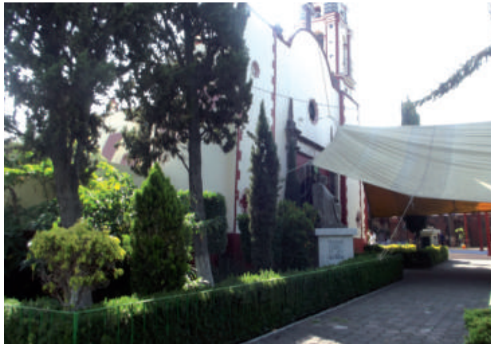
Figura 5.70. Fotografía A de la zona de riesgo. Inclinación de la iglesia debido al peso de la torre y las campanas. El desnivel que se registra es de 15 cm respecto a la parte oeste del inmueble (19.2462° N, 99.0737° W. Calle: Carrillo Puerto).
