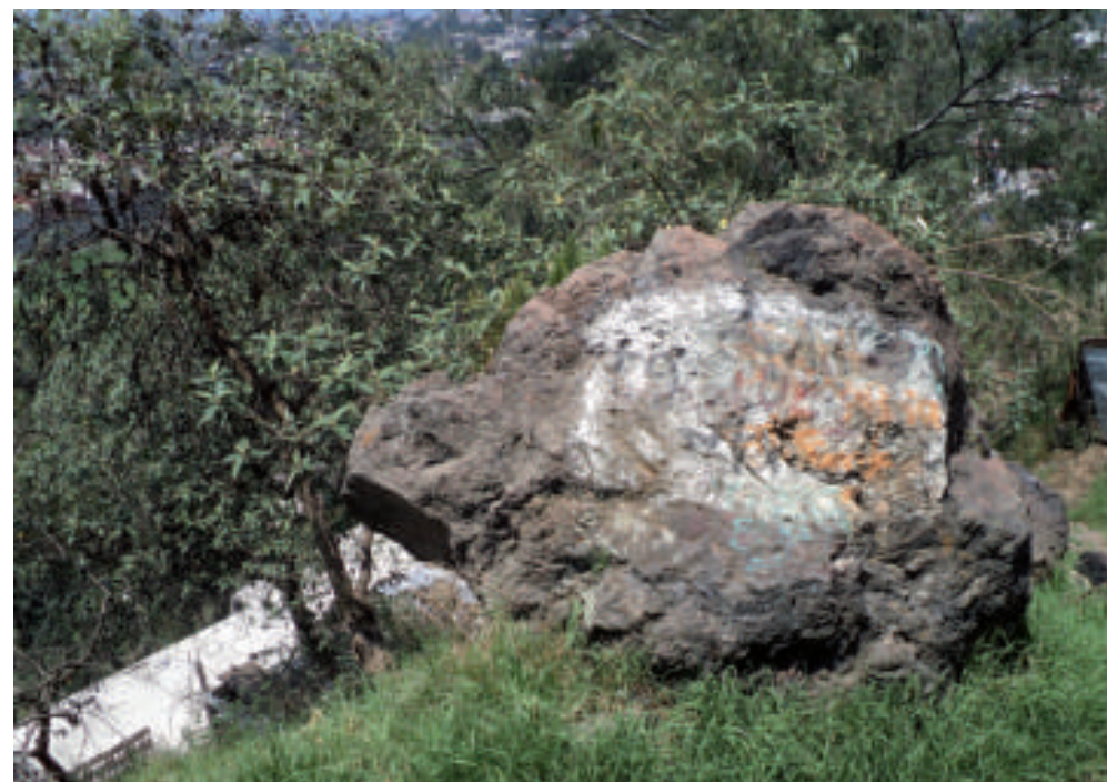
Figura 5.9. Fotografía C en los polígonos de peligro y vulnerabilidad. Posible caída de rocas a las viviendas situadas en la parte baja de la ladera (19.2269° N, 99.1362° W. Calle: sin nombre oficial).
