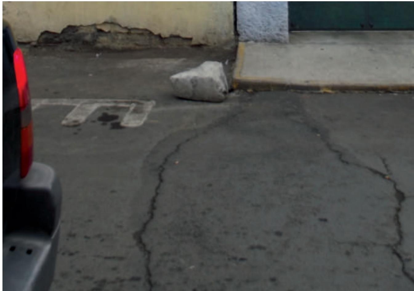
Figura 5.50. Fotografía B del polígono de riesgo. Vía de comunicación afectada por una fractura (19.2536° N, 99.0101° W. Calle: Nicolás Bravo).
