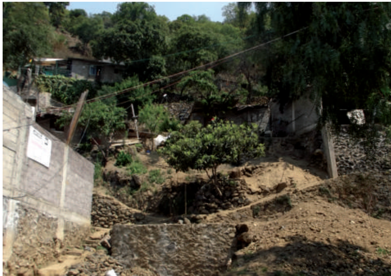
Figura 5.34. Fotografía A de los polígonos de peligro y vulnerabilidad. Construcciones vulnerables ante un derrumbe en el cerro Tezontitla a pesar de contar con obras de mitigación (19.2250° N, 99.0947° W. Calle: Camino Real a San Bartolo).
