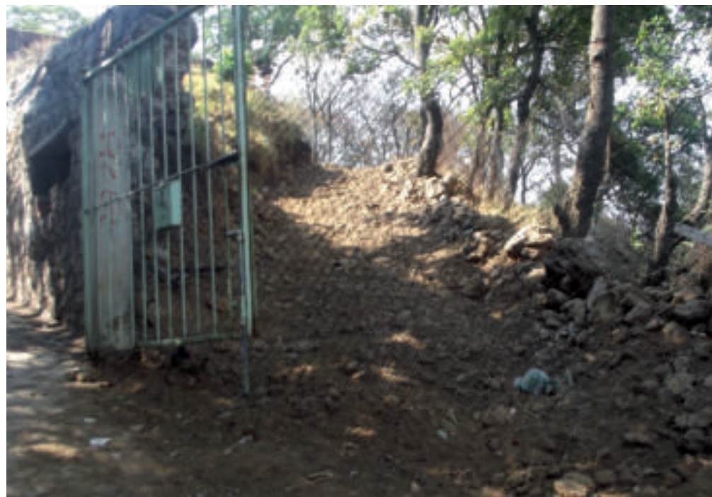
Figura 5.13. Fotografía B en los polígonos de peligro y vulnerabilidad. Medida de mitigación realizada en la calle Camino al Panteón (19.2142° N, 99.1000° W. Calle: Camino al Panteón).
