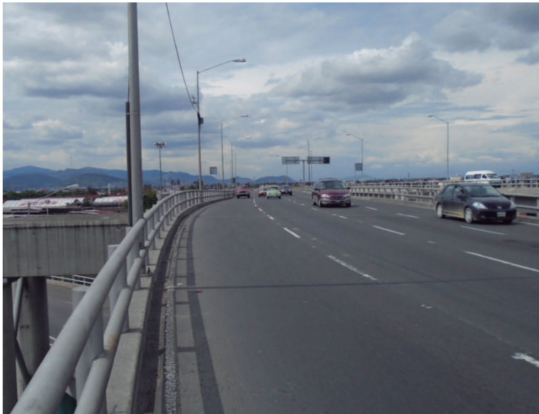
Distribuidor vial Heberto Castillo, colonia Moctezuma 1. ª Sección.
