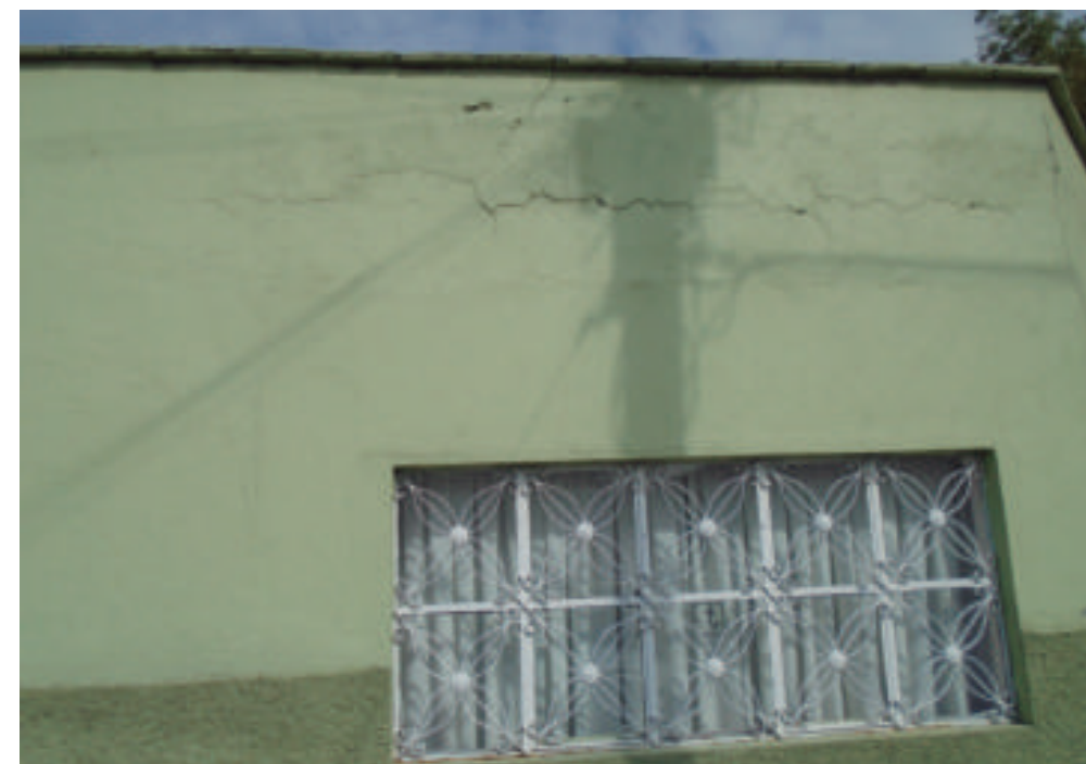
Figura 5.64. Fotografía B de la colonia Romero Rubio. Inmueble con fracturas en la parte superior de la construcción (19.4433° N, 99.0930° W. Calle: Siberia).
