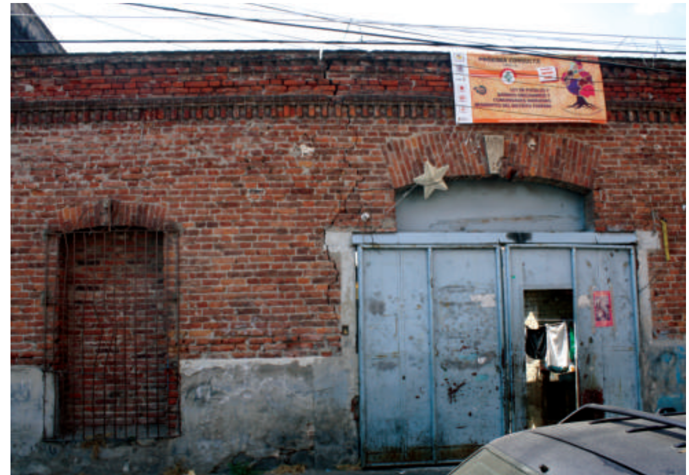
Figura 5.236. Fotografía C de la colonia Merced Balbuena. Muro del inmueble afectado por fracturas verticales (19.4200° N, 99.1250° W. Calle: Privada Ixnahualtongo).
