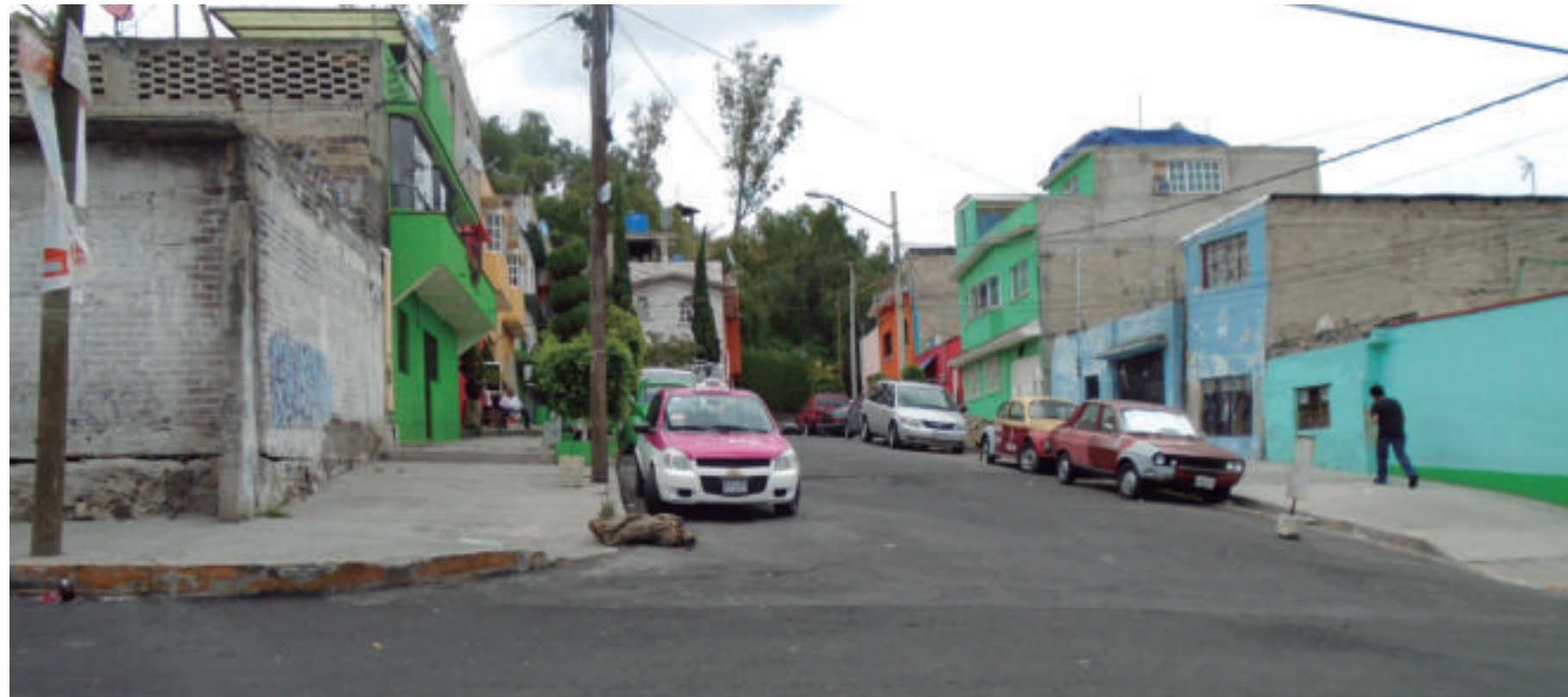
Fracturamiento que atraviesa la calle y afecta las viviendas de la colonia Peñón de los Baños.
