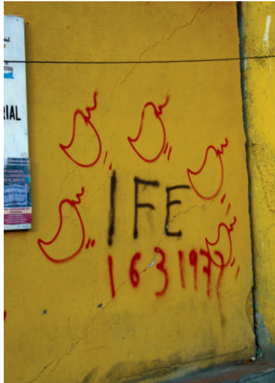
Figura 5.230. Fotografía C de la colonia Centro. Separación en la junta constructiva y fracturas diagonales en el muro del inmueble (19.4228° N, 99.1217° W. Calle: Fray Servando Teresa de Mier).
