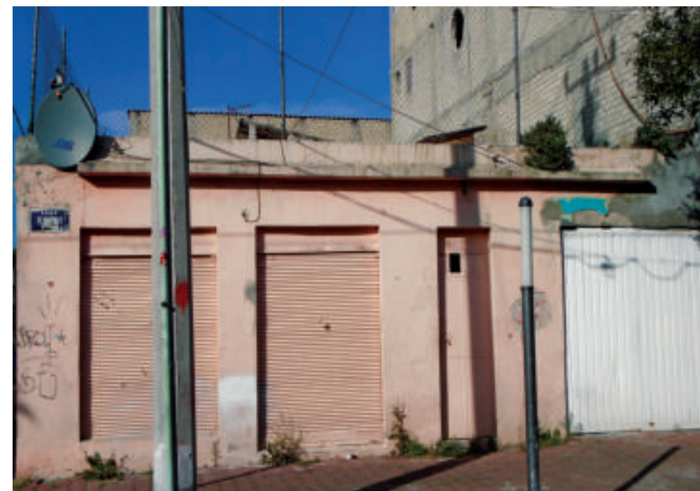
Figura 5.85. Fotografía B de la colonia Ampliación Michoacana. Inmueble con daños en el acabado (19.4472° N, 99.1126° W. Calle: Maravillas).
