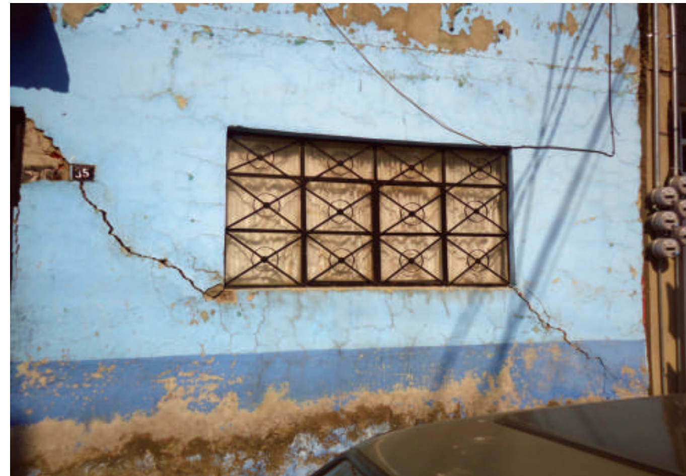
Figura 5.206. Fotografía A de la colonia Valentín Gómez Farías. Se observan 2 fracturas, una de ellas va desde la parte superior de la puerta hasta parte inferior de la ventana y la otra de la parte inferior de la ventana hacia la junta constructiva (19.4143° N, 99.0900° W. Calle: 37).
