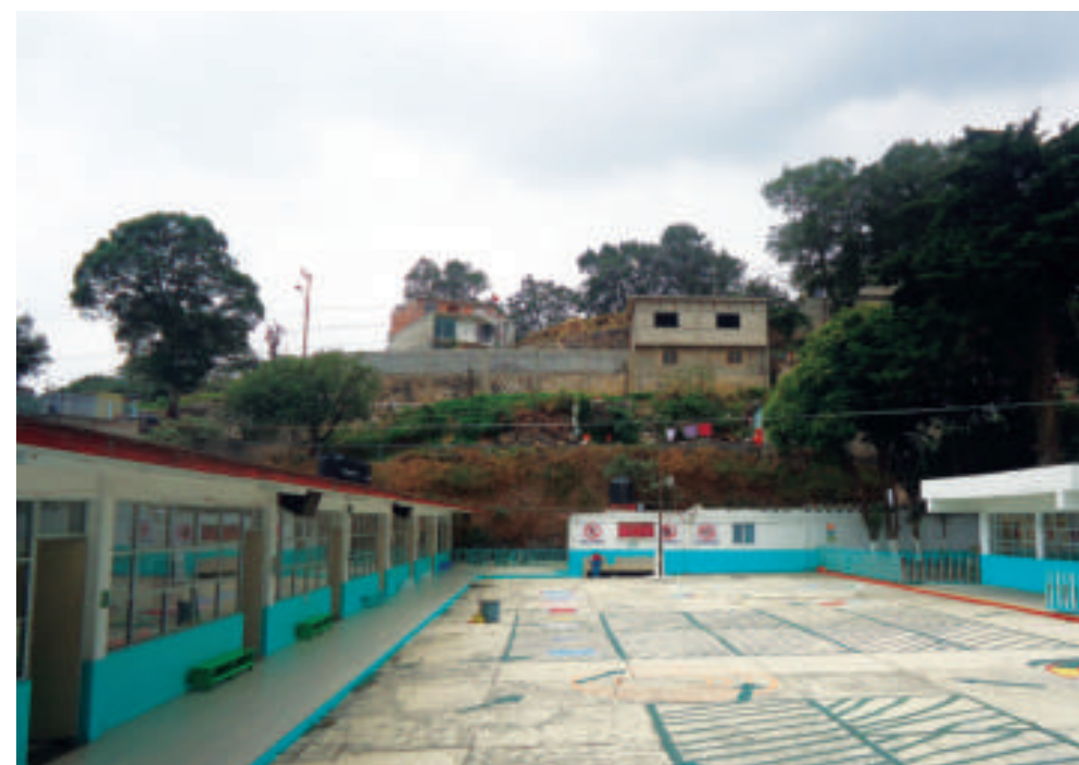
Figura 5.37. Fotografía B en el polígono de vulnerabilidad. Jardín de niños «Topilli». Al fondo se observa un talud con una altura de 5 m, que se ubica a 1 m de distancia de las aulas y la conserjería (19.9152° N, 99.1440° W. Calle: Santa Cruz).
