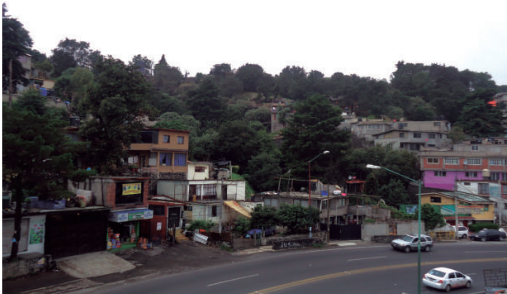
Figura 5.68. Fotografía B en el polígono de peligro. Vista panorámica de la barranca. Se observan viviendas asentadas sobre los límites y dentro de la barranca (19.5027° N, 99.1762° W. Calle: Federal a Cuernavaca).
