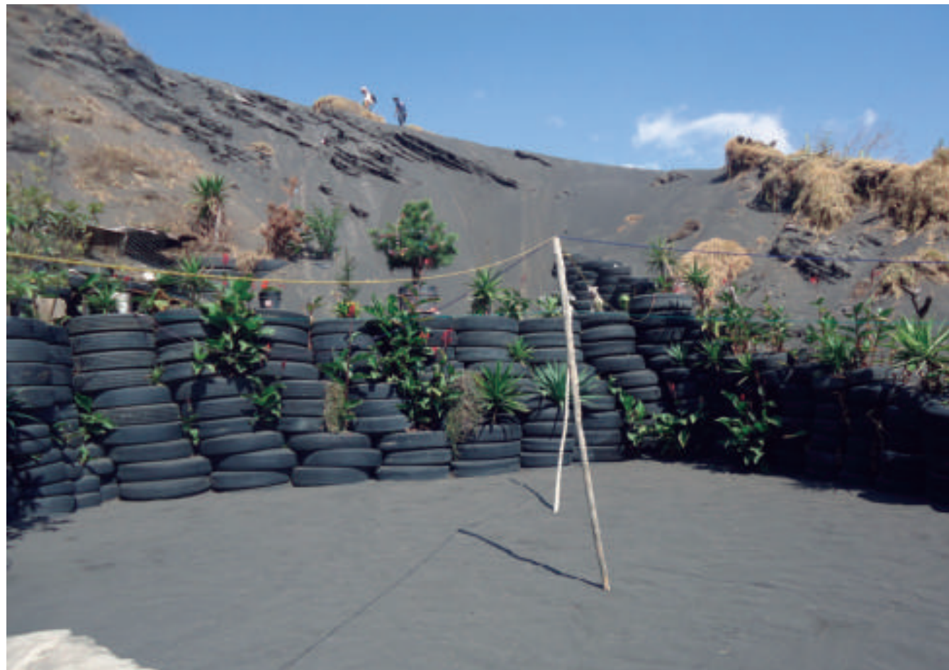
Figura 5.20. Fotografía D en el polígono de vulnerabilidad. Vivienda afectada por el deslizamiento de la ceniza. A espaldas de la vivienda un muro de contención con llantas (19.3374° N, 99.1841° W. Calle: Río Seco).
