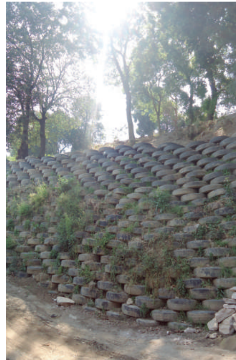
Muro de contención hecho con llantas para poder detener los materiales inestables.
