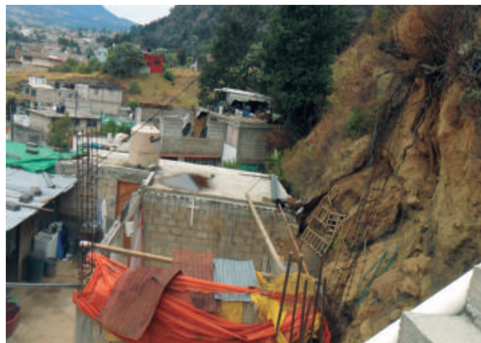
Figura 5.31. Fotografía C en el polígono de vulnerabilidad. Viviendas cercanas al talud propenso al derrumbe y/o caída de rocas (19.0802° N, 99.1359° W. Calle: 5ta de Morelos).
