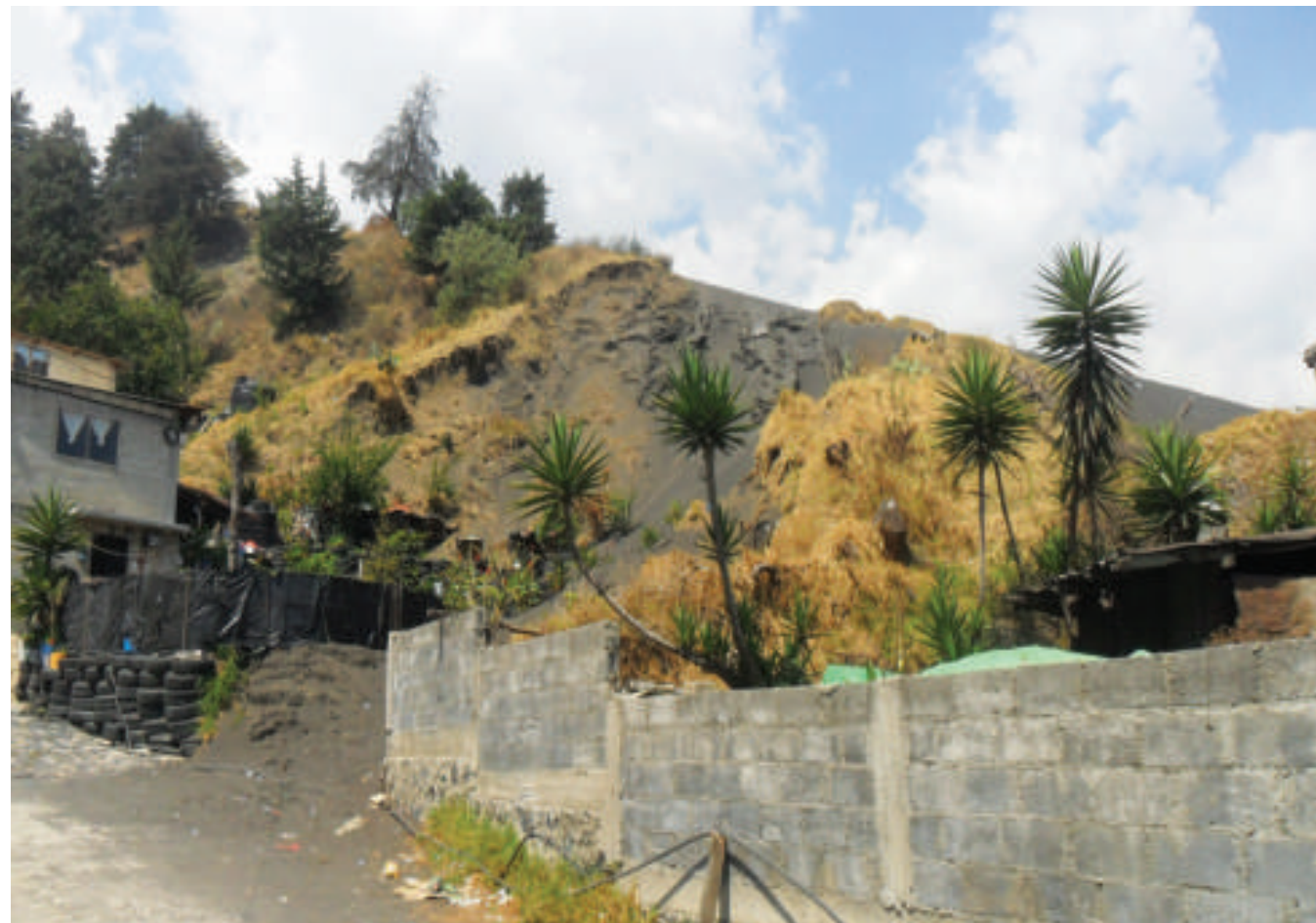
Figura 5.18. Fotografía B en el polígono de vulnerabilidad.
