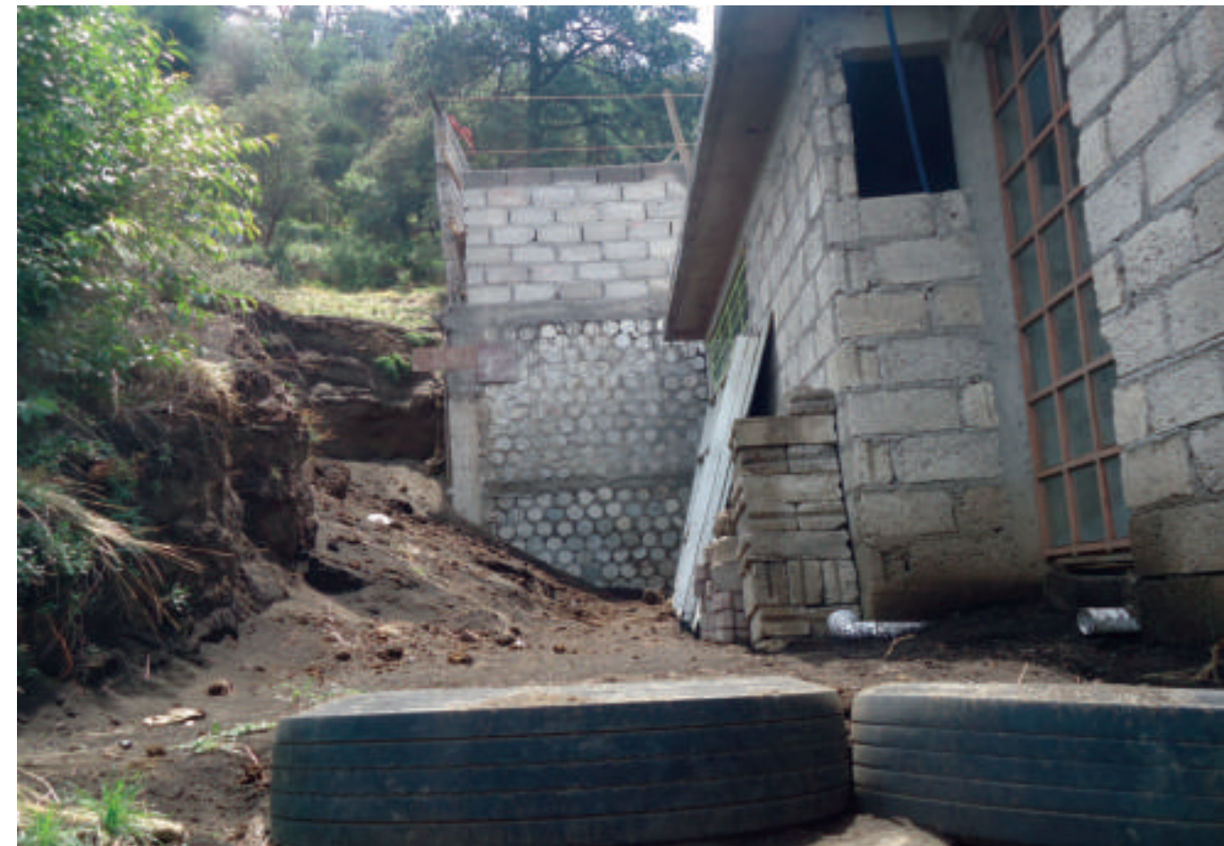
Figura 5.48. Fotografía B en el polígono de vulnerabilidad.
