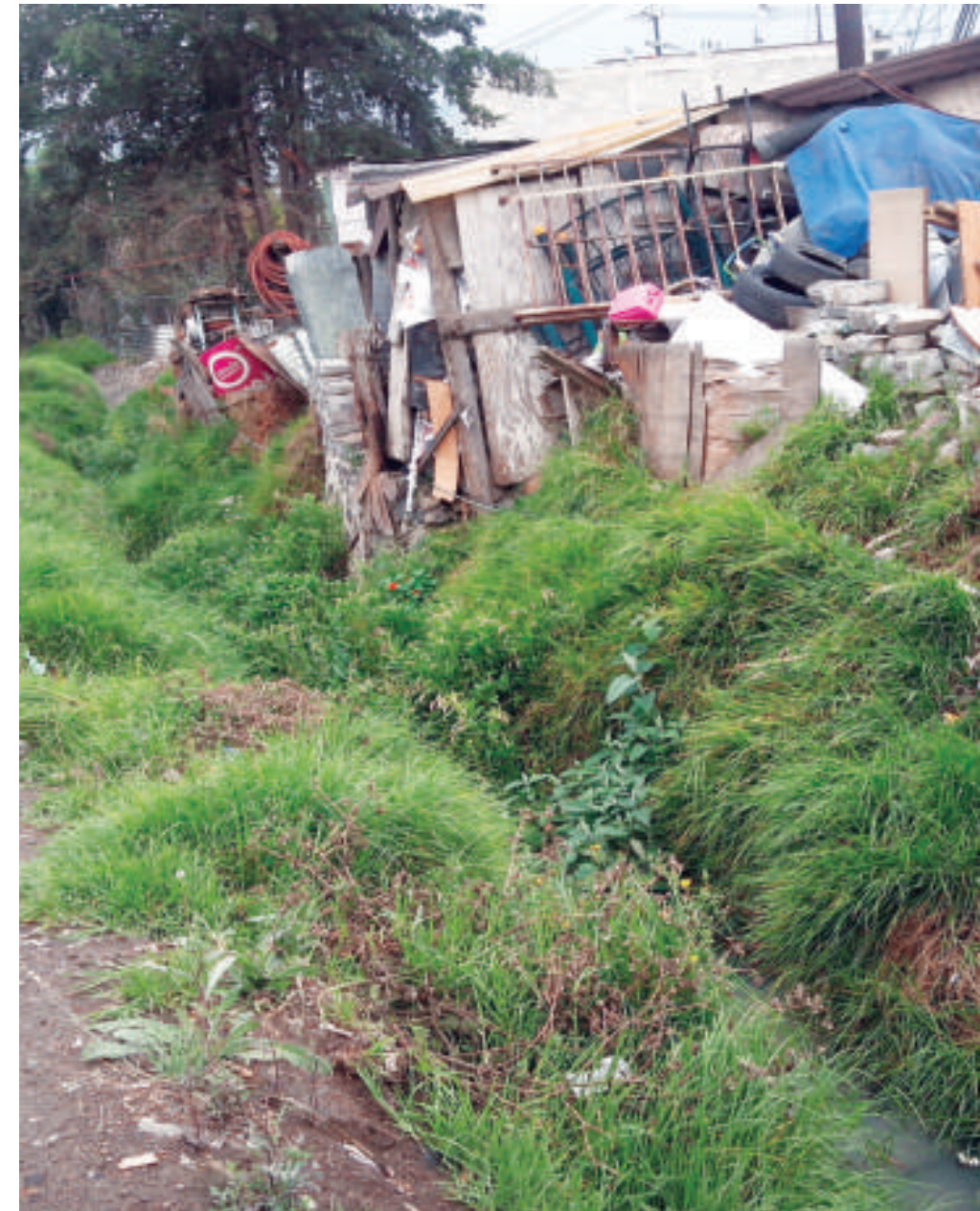
Figura 5.57. Fotografía B en el polígono de peligro. La inestabilidad de los materiales en las laderas y la erosión por la fuerza del agua en el río han provocado que las construcciones queden sin basamento (19.9983° N, 99.2326° W. Calle: Cansahcab).
