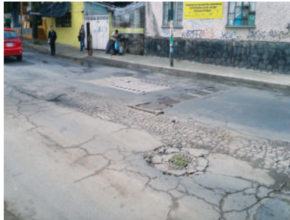
Figura 5.72. Fotografía B. Hundimiento en dirección del drenaje en la calle Tekal (19.2837° N, 99.2197° W. Calle: Tekal).
