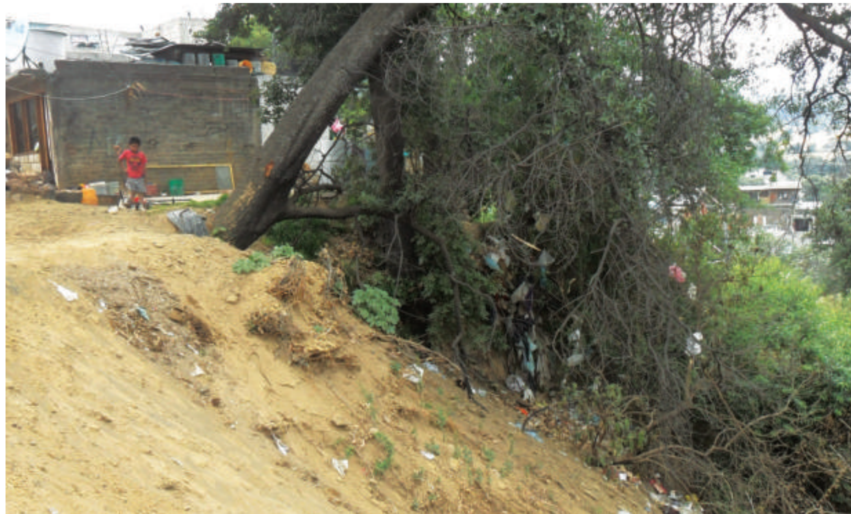
Figura 5.34. Fotografía A en el polígono de peligro. Los materiales (limos y arcillas) se erosionan fácilmente y la ladera es inestable. Se observa inclinación del árbol en dirección de la misma (19.9152° N, 99.1440° W. Calle: Las Granjas).
