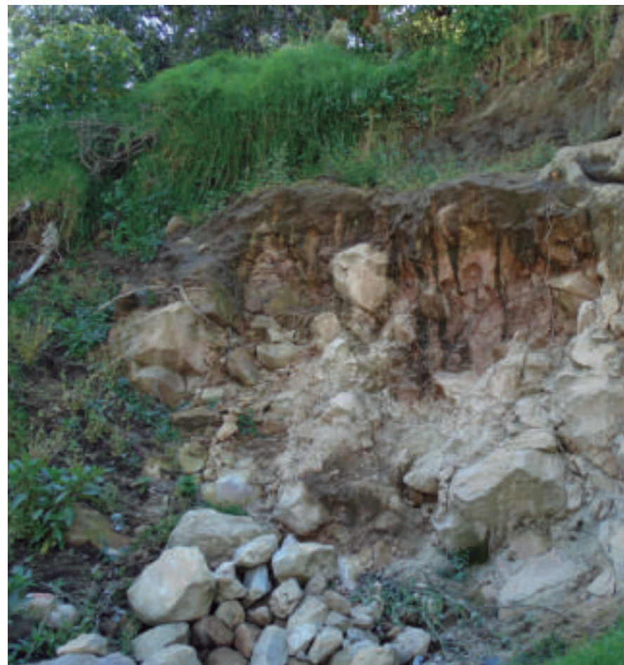
La caída de roca es un peligro presente en la delegación. La fotografía corresponde a La Magdalena Petlalcalco.
