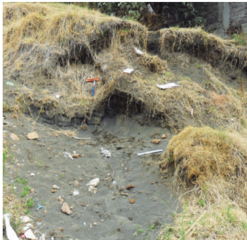
Figura 5.29. Fotografía B en el polígono de vulnerabilidad.
