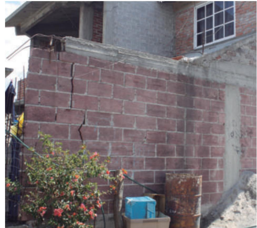
*Figura 5.106. Fotografía A del polígono de vulnerabilidad. Las construcciones presentan fracturas debido al movimiento del terreno, así como también a la mala construcción y empleo de materiales poco resistentes (19.1727° N, 98.9915° W. Calle: Prolongación Ignacio Zaragoza).*
