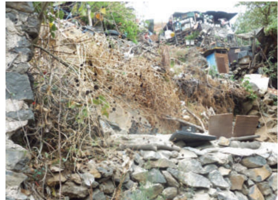
*Figura 5.60. Fotografía C del polígono de vulnerabilidad. Edificación de viviendas sobre la ladera inestable; estos predios son principalmente asentamientos humanos contruidos con madera y lámina sobre mampostería sin mortero (19.2033° N, 99.0414° W. Calle: Miguel Hidalgo).*
