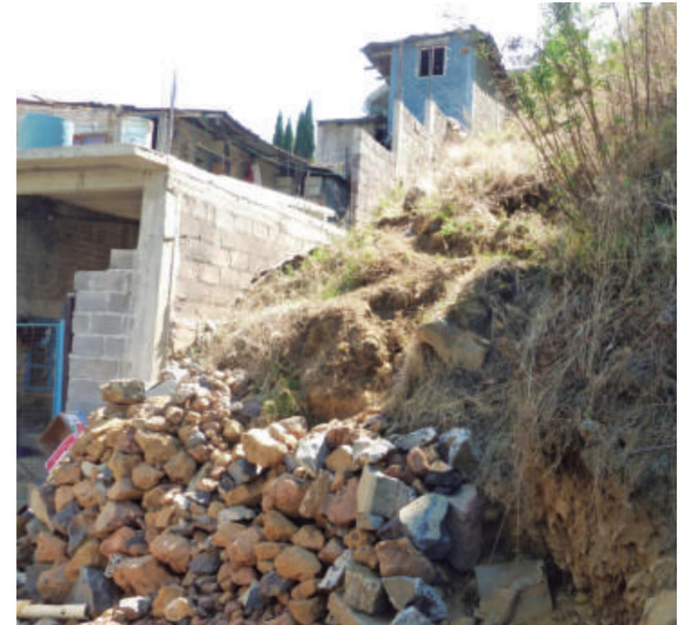
*Figura 5.36. Fotografía C del polígono de vulnerabilidad. Muro de roca acomodada con el fin de mitigar los daños por flujos de lodo (19.2004° N, 99.1007° W. Calle: Paraje Tlacochemicalco).*
