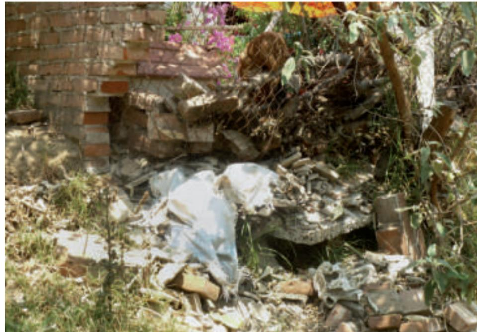
*Figura 5.82. Fotografía A del polígono de peligro. Vivienda con severos daños ocasionados por el flujo de lodo, esto se observa debido a la barda caída y a la acumulación de basura. La vivienda se encuentra construida sobre material de relleno (19.1885° N, 99.0639° W. Calle: Benito Juárez).*
