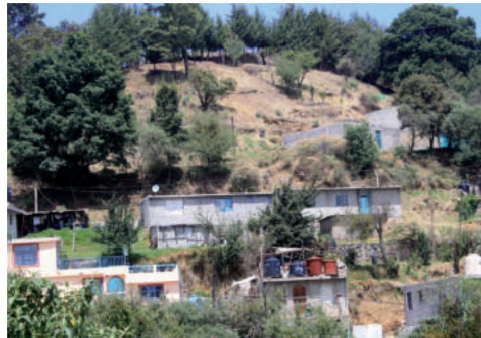
**Figura 5.27. Fotografía C del polígono de vulnerabilidad.** Cortes de una ladera (con una longitud de 44.87 m) en la que se han construido viviendas de manera escalonada sobre la pendiente; la deforestación ha desestabilizado la ladera de tal forma que pueden presentarse eventos de caída de rocas sobre las viviendas (19.1856° N, 99.0957° W. Calle: sin nombre oficial, cerro Paraje Coatepec).
