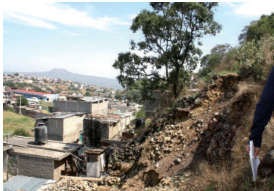
*Figura 5.105. Fotografía B del polígono de peligro. Construcción de viviendas sobre material poco consolidado, susceptibles a daños por derrumbes del terreno y caída de rocas de la parte superior de la ladera (19.1710° N, 98.9912° W. Calle: Temixco).*
