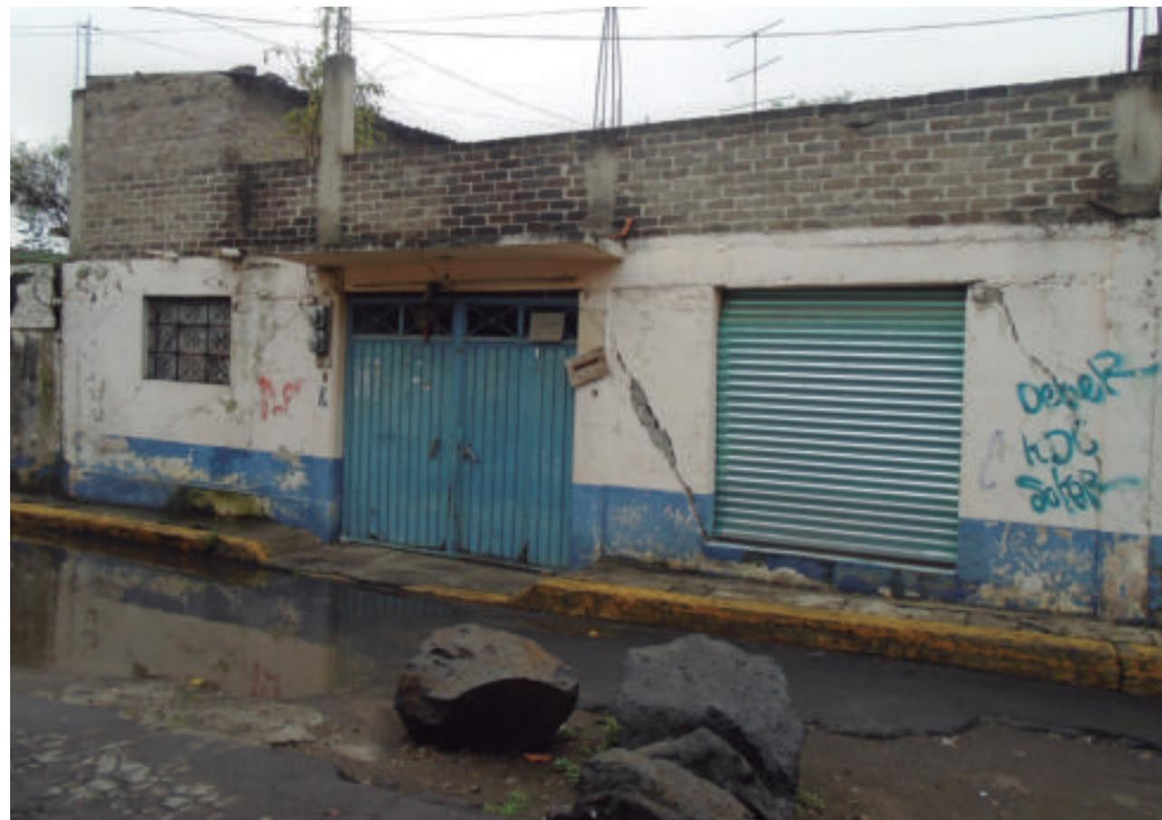
*Figura 5.121. Fotografía B de la zona de hundimiento y fracturamiento. Afectación y daño estructural que presenta la vivienda y que actualmente se encuentra deshabitada. La calle ya no es transitada (19.2151° N, 98.9913° W. Calle: Vicente Guerrero).*
