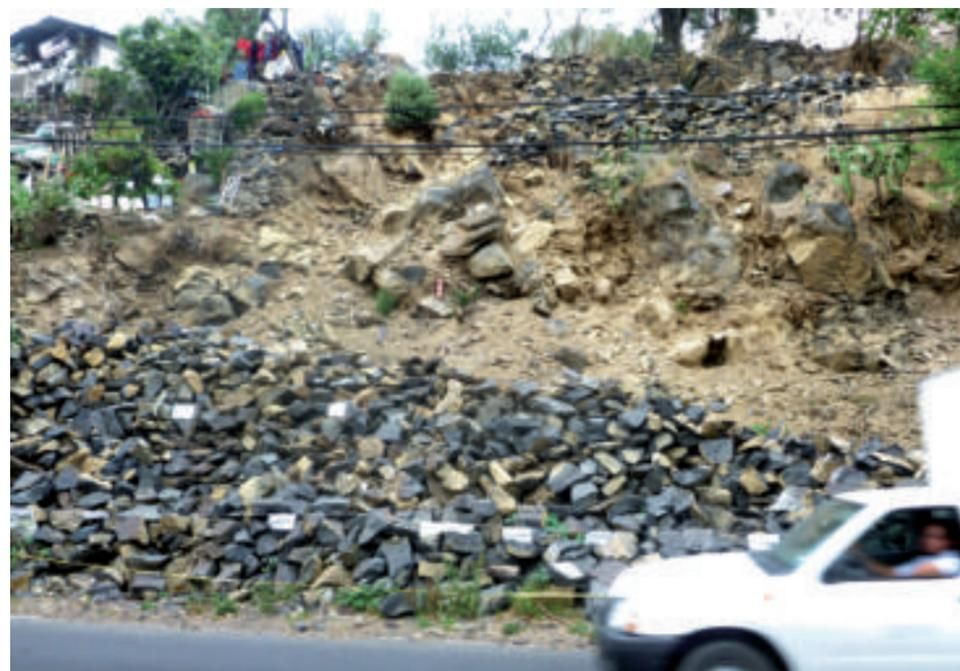
*Figura 5.59. Fotografía B del polígono de vulnerabilidad. Peligro por derrumbe provocado por la inestabilidad del muro de mampostería sin mortero (19.2033° N, 99.0412° W. Calle: Miguel Hidalgo).*
