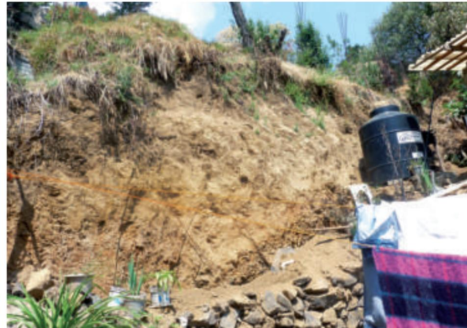
**Figura 5.26. Fotografía B del polígono de vulnerabilidad.** Corte hecho sobre la ladera compuesto por material fino (arcillas), el cual tiende a caer sobre la vivienda debido a su inestabilidad. Esto significa un peligro para los habitantes; dicha situación se observa constantemente a lo largo del polígono (19.1847° N, 99.0945° W. Calle: sin nombre oficial, cerro Paraje Coatepec).
