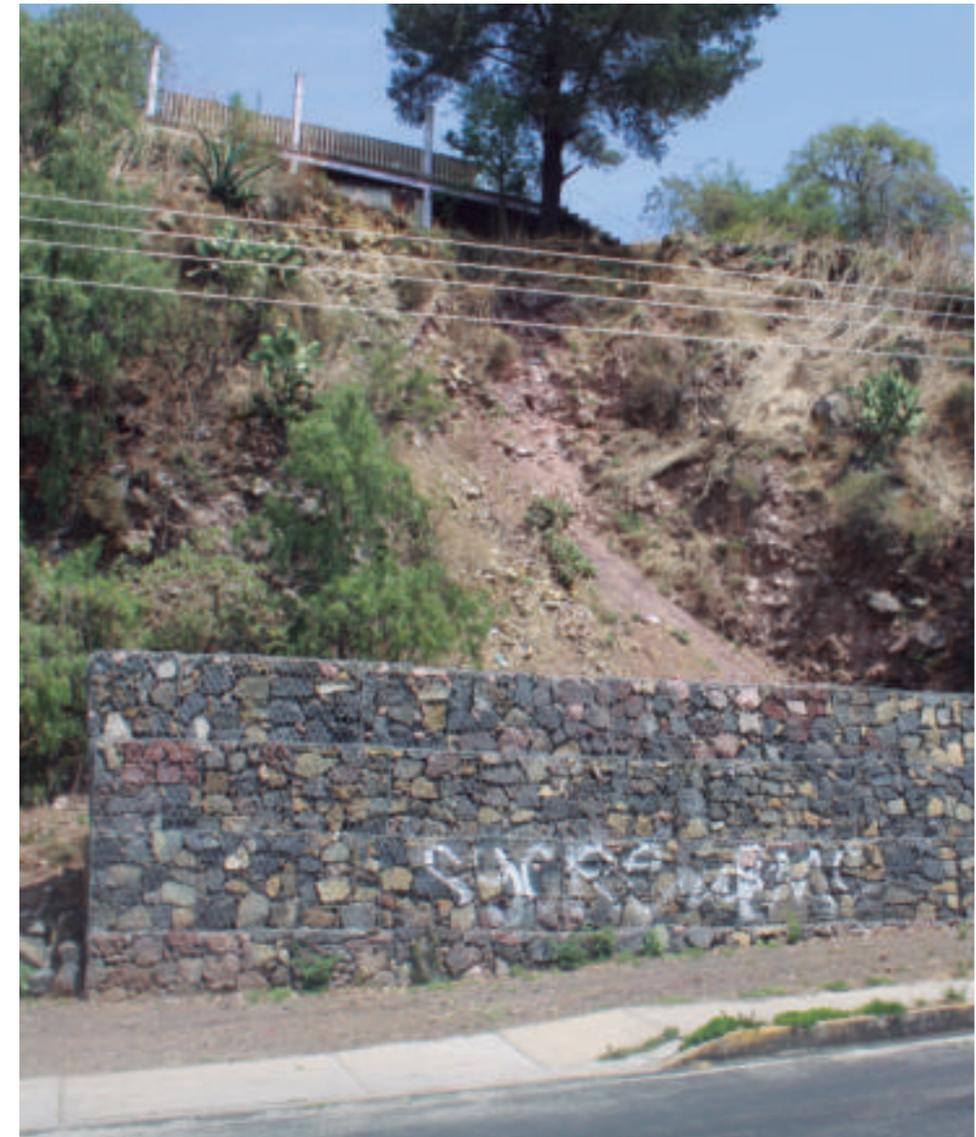
*Figura 5.70. Fotografía C del polígono de vulnerabilidad. Derrumbe ocurrido hace dos años sobre la avenida Jalisco. La obra de mitigación (muro de contención) construida después del derrumbe tiene dimensiones que resultarían insuficientes en caso de ocurrir nuevamente el mismo siniestro. Asimismo se observa que la vivienda localizada en la parte superior es susceptible a sufrir un daño debido a derrumbes del terreno (19.2000° N, 99.0352° W. Avenida: Jalisco Oriente).*
