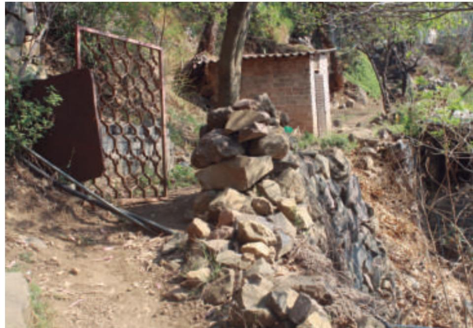
*Figura 5.68. Fotografía A del polígono de vulnerabilidad. Vivienda construida a la orilla de la barranca susceptible a sufrir daños por derrumbe del terreno o por caída de roca (19.2003° N, 99.0350° W. Avenida: Jalisco Oriente).*
