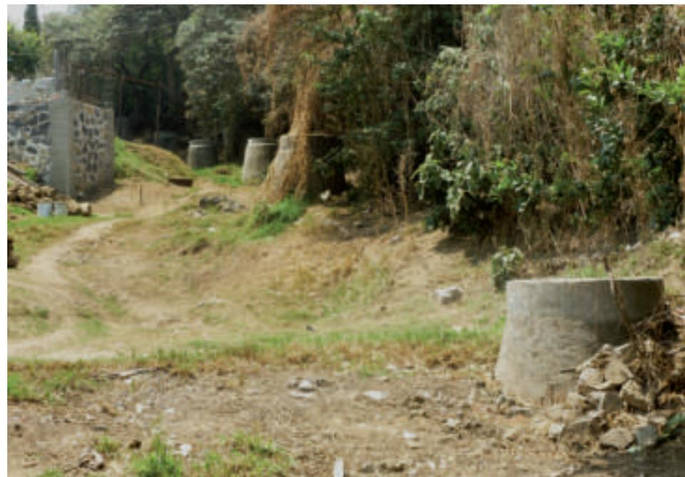
*Figura 5.83. Fotografía B del polígono de peligro. Construcción de pozos de visita y la construcción de nuevas viviendas a orillas de la barranca. El drenaje de la barranca fluye a través de la geometría del camino (19.1881° N, 99.0638° W. Calle: sin nombre oficial).*
