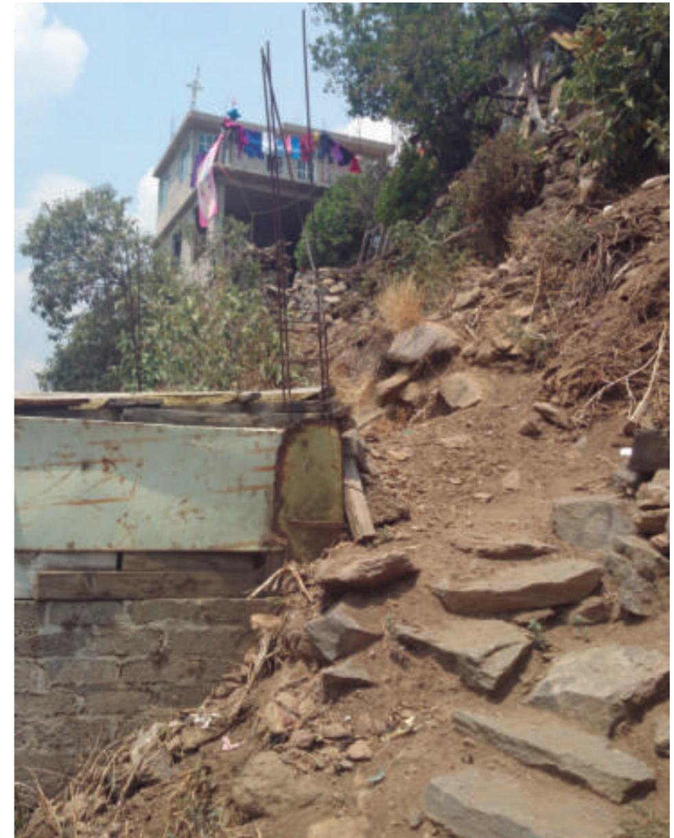
**Figura 5.44. Fotografía B del polígono de peligro.** Viviendas vulnerables ante derrumbes y desprendimiento de roca en el Paraje Tepexomulco. En la parte superior se observa un camino improvisado con rocas de más de 30 cm de diámetro (19.2018° N, 99.0587° W. Calle: Camino a San Bartolo).
