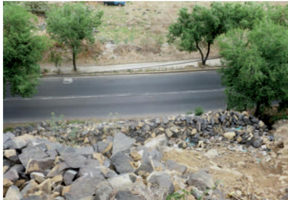
*Figura 5.58. Fotografía A del polígono de vulnerabilidad. Muro de mampostería sin mortero susceptible a derrumbarse, lo cual provocaría daño a los autos que transitan por esta vía de comunicación, Paraje Tetecolotl (19.2034° N, 99.0413° W. Calle: Miguel Hidalgo).*
