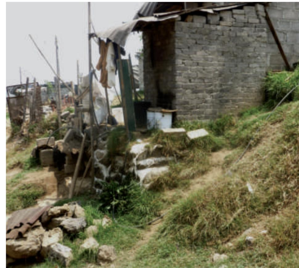
*Figura 5.84 Fotografía C del polígono de peligro. Construcción de una vivienda con paredes de tabique y techo de lámina dentro de la barranca. Se puede observar que corre el drenaje dentro de la barranca del Paraje Ahuatitla (19.1884° N, 99.0641° W. Calle: Benito Juárez).*
