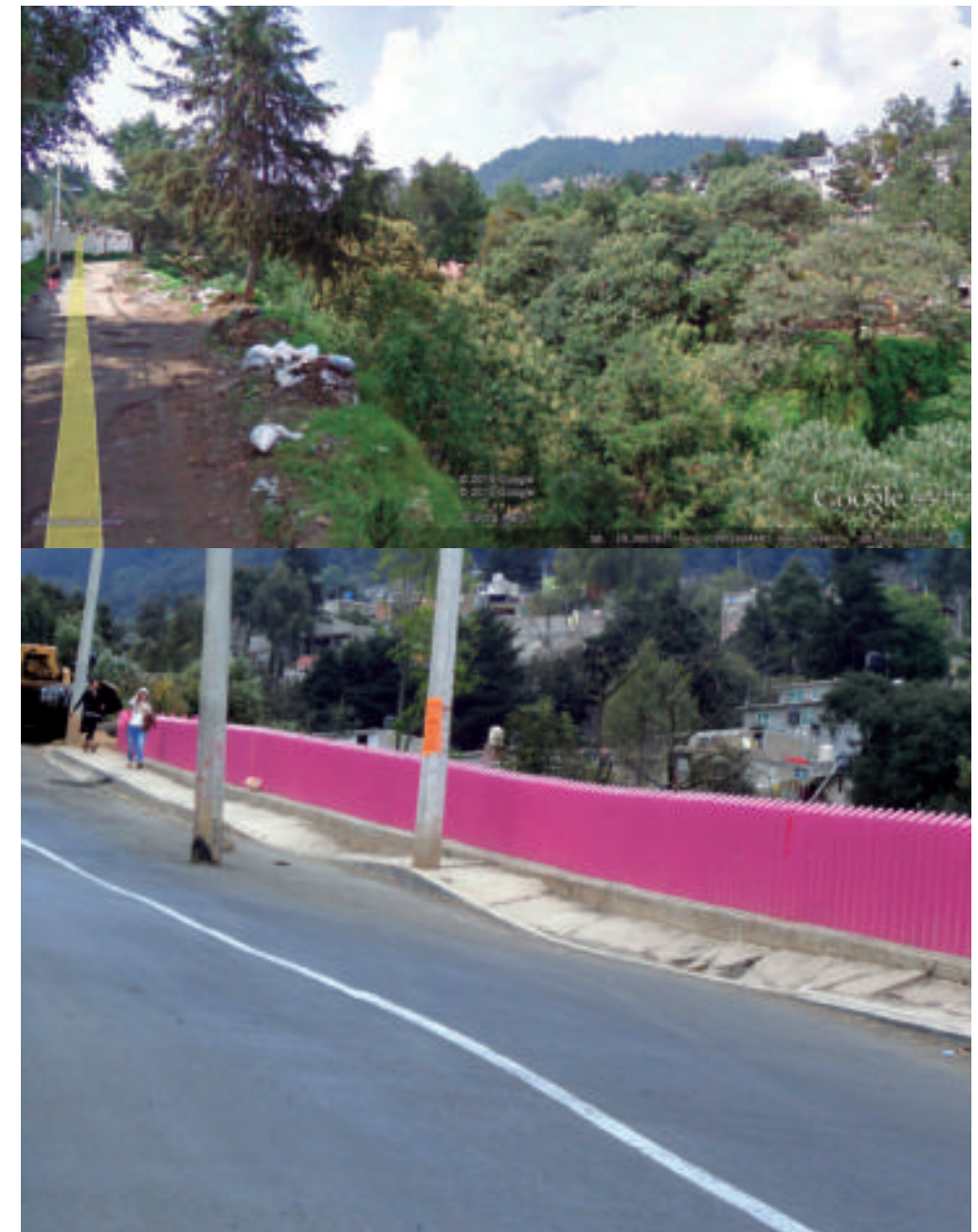
Figura 5.49. Fotografía A de la sección tres (4.3) de Anzaldo. La fotografía superior muestra el cauce original de la barranca en 2009 (Fotografía obtenida de Google Earth), y en la fotografía inferior se observa la deformación en la carpeta asfáltica en la actualidad (19.3062° N, 99.2587° W. Calle: Coconetla).
