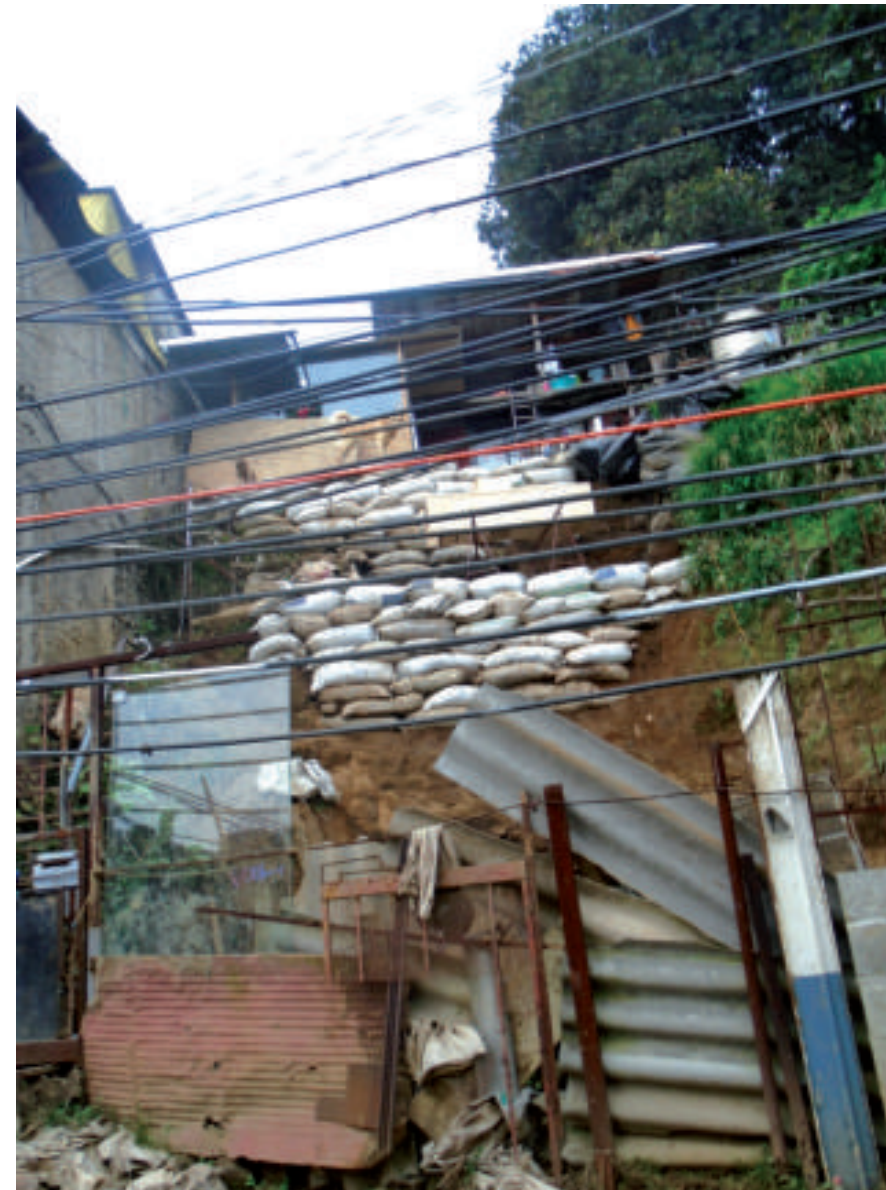
Figura 5.97. Fotografía B en el polígono de peligro Tierra Colorada. Talud hecho para la construcción de la vivienda, el cual es contenido con muros de costales para evitar la remoción de los materiales finos y bloques (19,2735° N, 99,2473° W. Calle: Acros).
