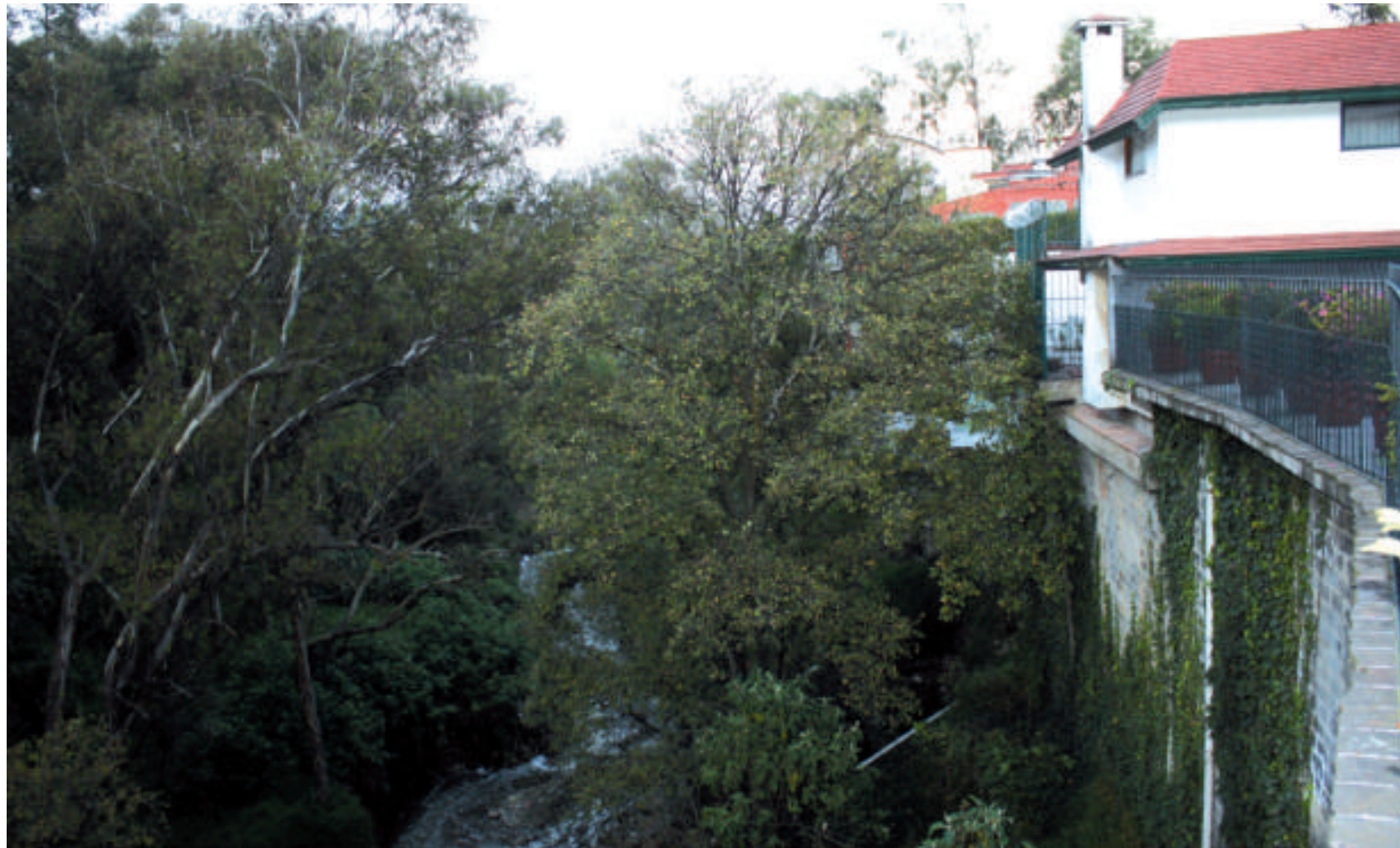
Figura 5.17. Fotografía A de la sección dos (2.2) de Texcalatlaco. Condominio establecido en el límite de la barranca. En la parte inferior de la imagen se puede observar el flujo natural de agua y en el costado izquierdo se aprecian árboles inclinados, con el círculo rojo se resalta la separación del muro (19.3304° N, 99.2293° W. Avenida: San Bernabé).
