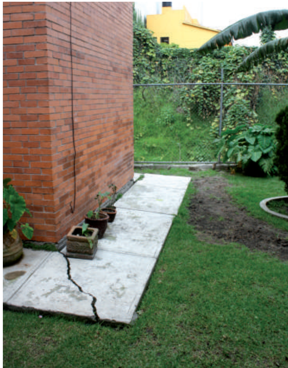
Figura 5.15. Fotografía C de la sección uno (2.1) de Texcalatlaco. Edificio de una zona habitacional que colinda con la barranca. En la parte inferior de la imagen se puede apreciar una fractura generada por el desplazamiento del terreno (19.3368° N, 99.2087° W. Avenida: San Bernabé casi esquina con Querétaro).
