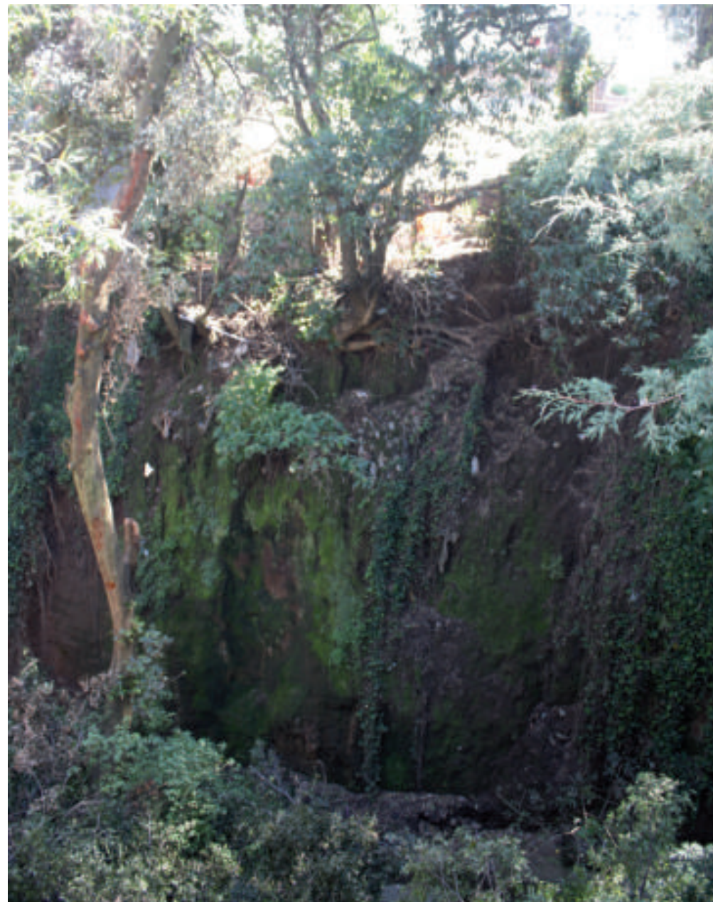
Figura 5.32. Fotografía E de la sección uno (3.1) de Coyotera. Las raíces expuestas de los árboles son un indicador de la pérdida de material (19.2250° N, 99.0947° W. Calle: Quetzalcóatl).
