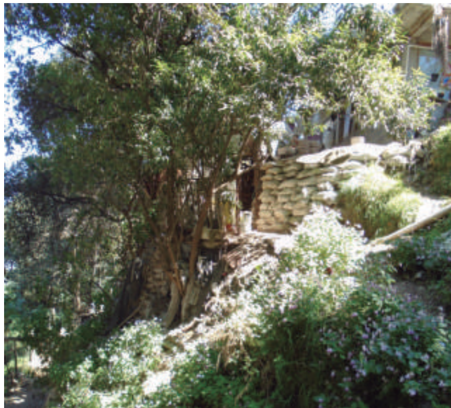
Vivienda en riesgo por fenómeno de remoción en masa en el pueblo San Nicolás Totolapan.
