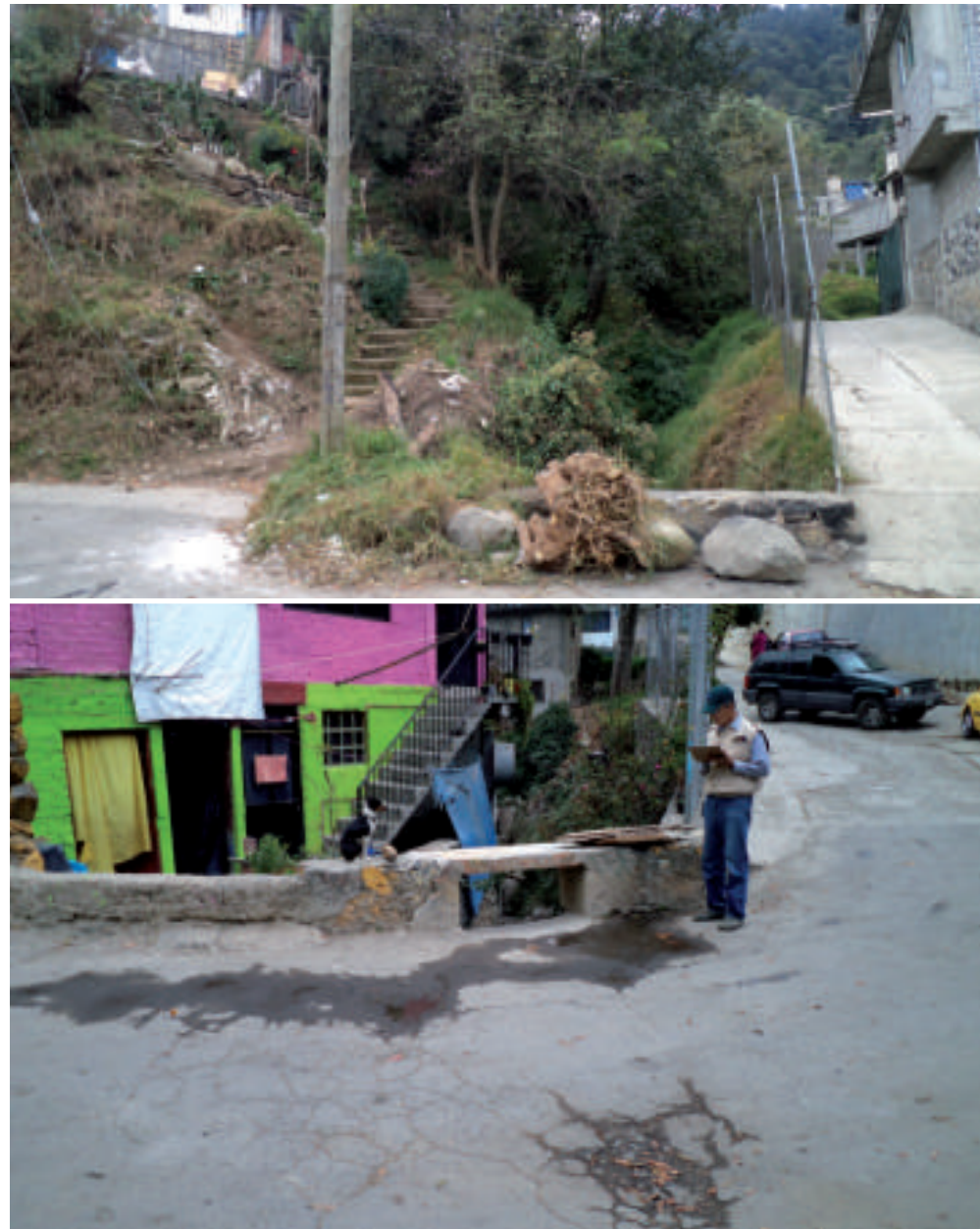
Figura 5.56. Fotografía D de la sección cuatro (4.4) de Anzaldo. Cambio de uso de suelo en la barranca. En la fotografía superior se aprecia la reducción del área hidráulica del cauce de la barranca por las viviendas establecidas en sus flancos. En la fotografía de abajo se muestra el otro lado de la calle donde existen viviendas sobre el cauce (19.3024° N, 99.2632° W. Calle: Flor de Loto).
