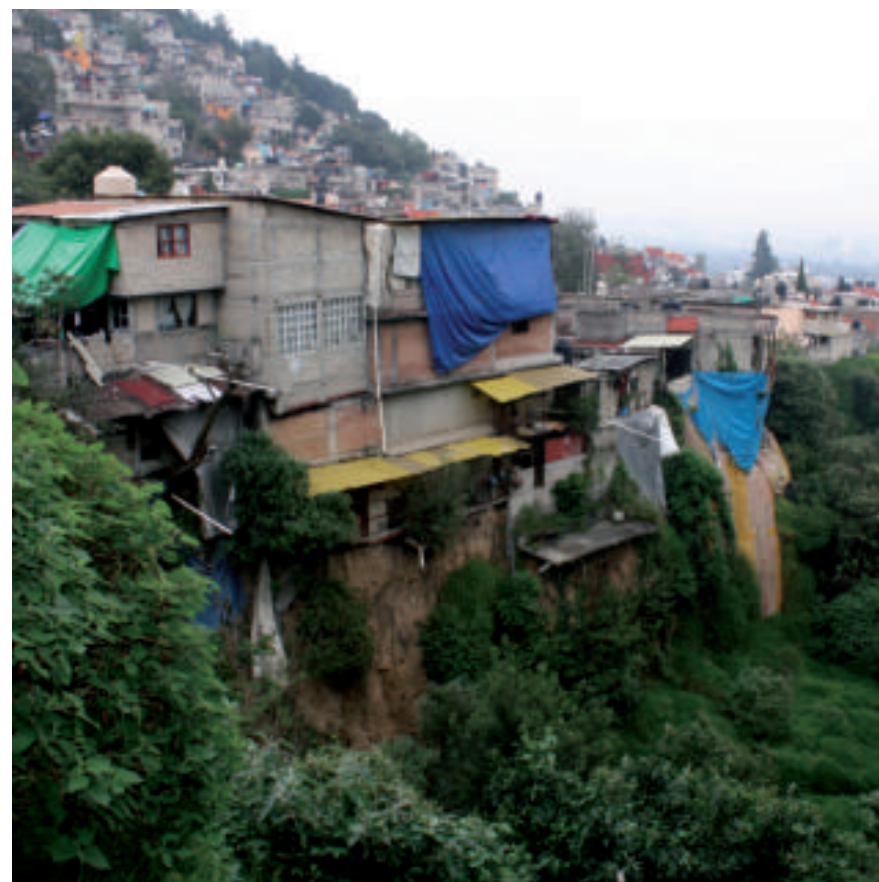
Figura 5.37. Fotografía D de la sección dos (3.2) de Coyotera. Vista panorámica de la barranca donde se aprecia un flanco del cauce. A la izquierda, las viviendas afectadas por derrumbes y la práctica de cubrir los materiales con lonas y plásticos para disminuir su erosión y movimiento (19.3162° N, 99.2517° W. Avenida: San Bernabé).
