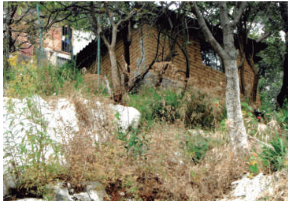
Figura 5.75. Fotografía A de vulnerabilidad en Sayula-Carbonera. Vivienda de adobe sin confinamiento y con presencia de fracturas en uno de los muros de carga. La fractura se encuentra asociada al movimiento del material sobre el que se encuentra desplantada (19,2984° N, 99,2567° W. Calle: Canal).
