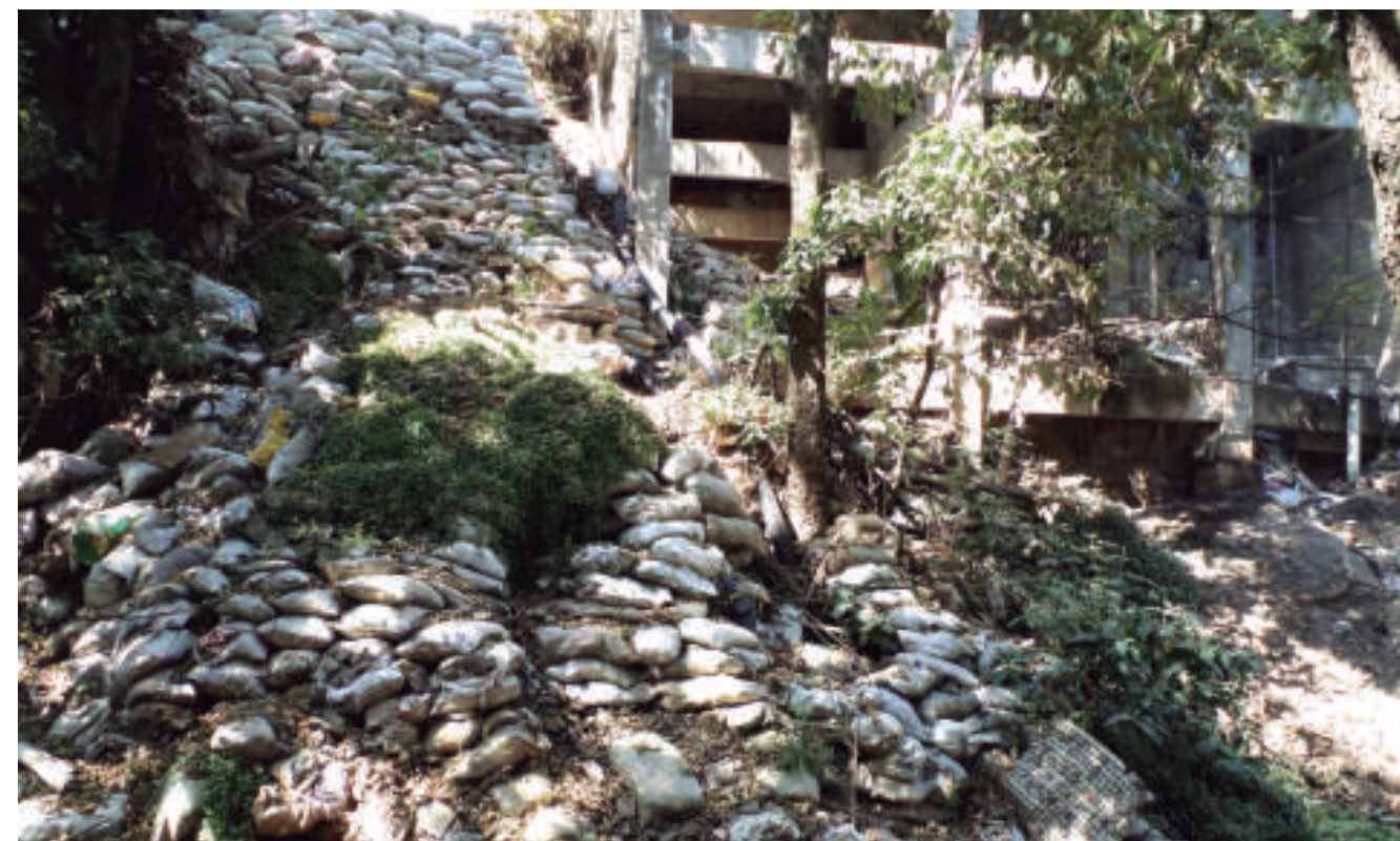
Vivienda construida en una de las paredes de la barranca Eslava. A un costado se muestra un muro de costales apilados ya derrumbado.
