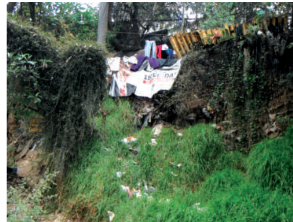
Figura 5.77. Fotografía C de vulnerabilidad en Sayula-Carbonera. Vivienda precaria desplantada en una pendiente pronunciada de materiales sin compactación y con evidencia de derrumbe (19,3017° N, 99,2497° W. Calle: Cañada).
