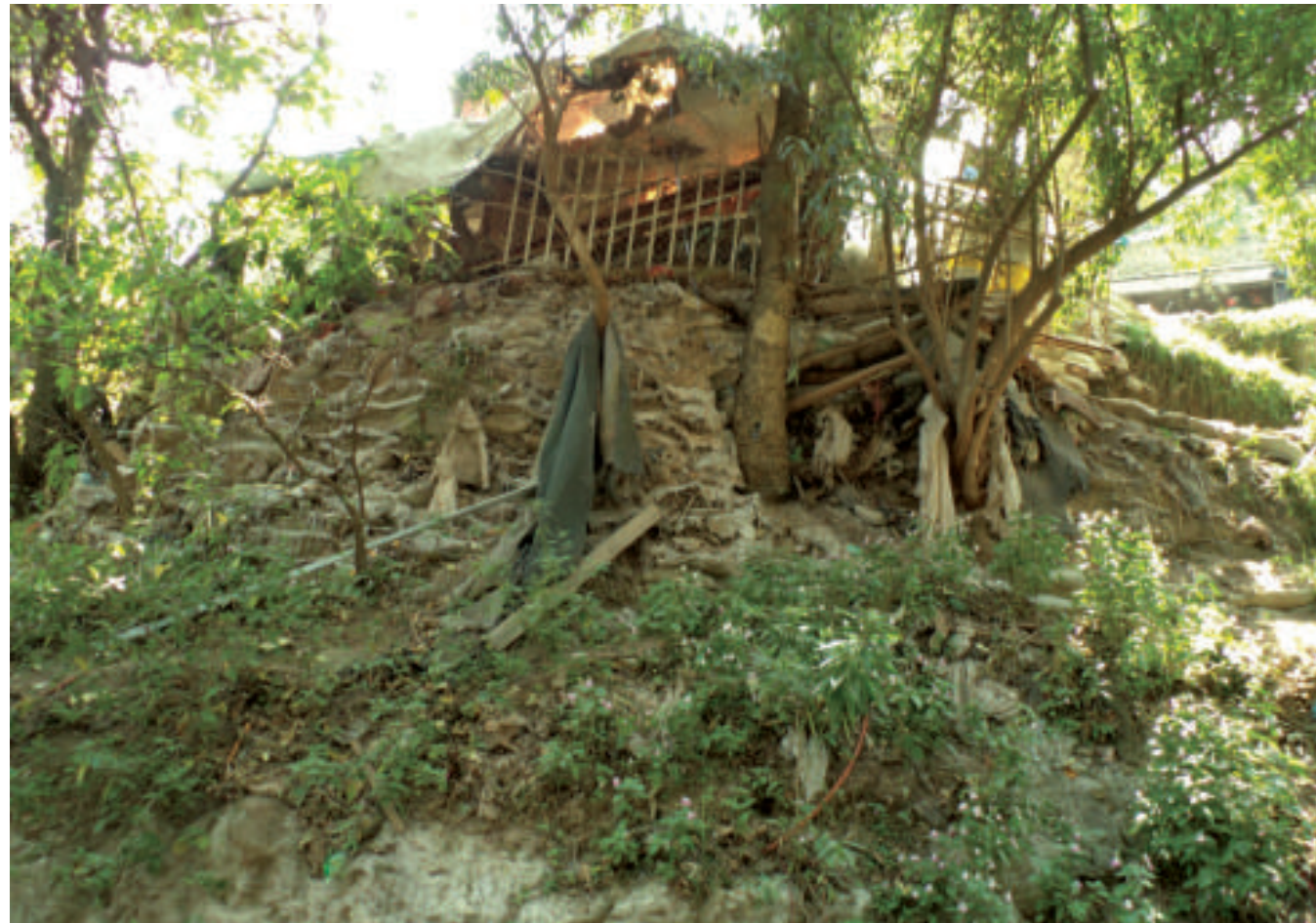
Figura 5.80. Fotografía A en el polígono de peligro Buenavista. Muros de contención provisionales con costales para estabilizar el suelo y evitar el derrumbe de material, además sirven como soporte para la vivienda (19.2957° N, 99.2540° W. Calle: Cañada).
