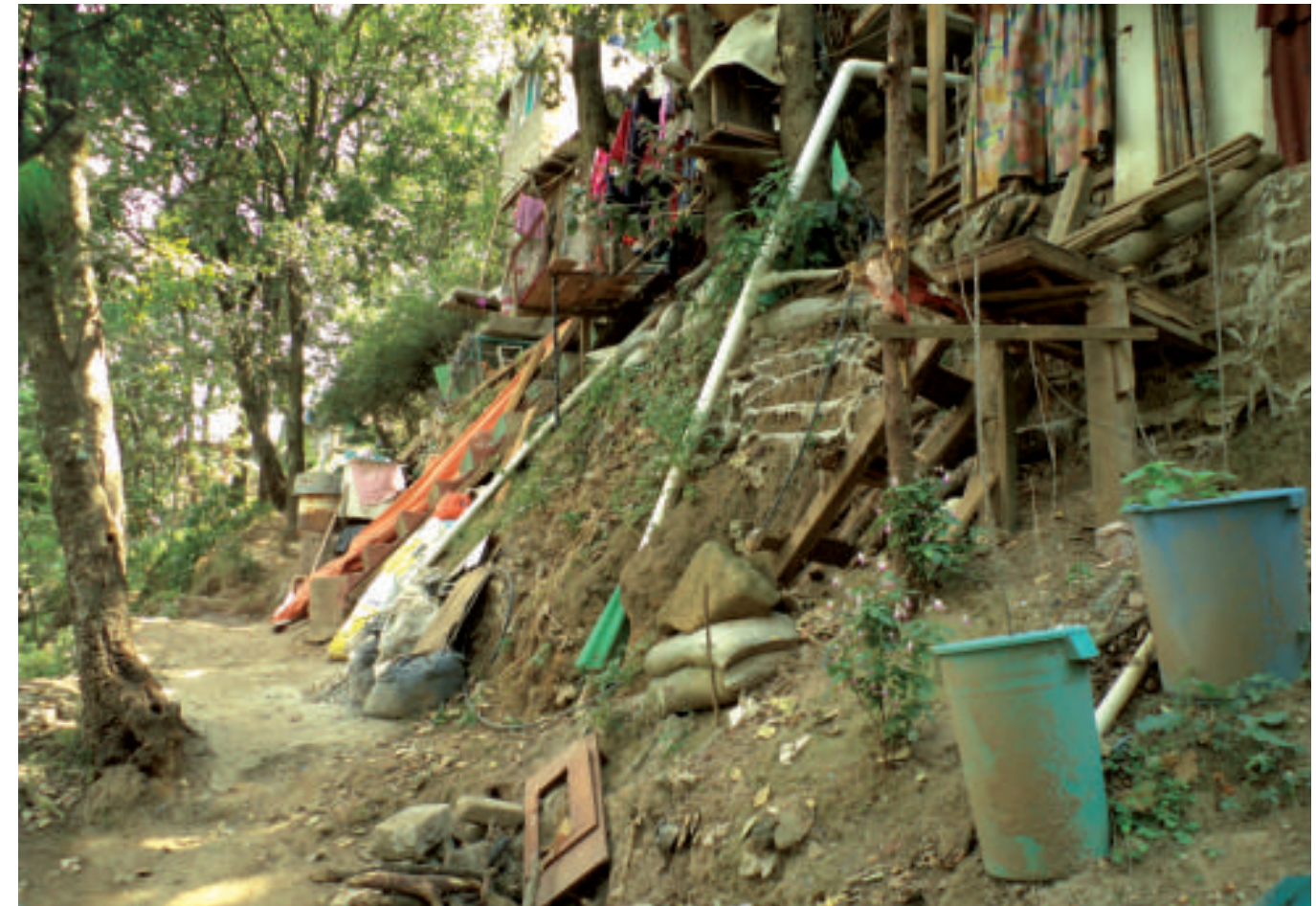
Figura 5.81. Fotografía B en el polígono de peligro Buenavista. Muros de contención provisionales para estabilizar el suelo, evitar derrumbes y delimitar un camino, además de que sirven de soporte para las viviendas precarias (19.2989° N, 99.2480° W. Calle: Sin Nombre oficial).
