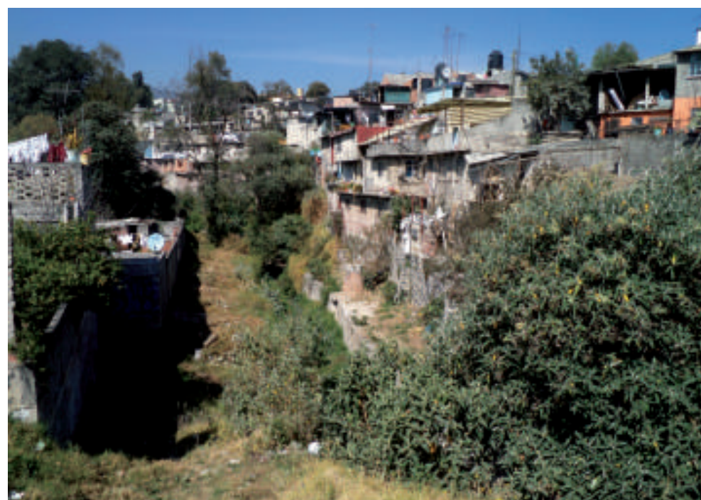
Figura 5.64. Fotografía A de la sección dos (5.2) de Eslava. Vista panorámica que ilustra asentamientos humanos en ambos flancos de la barranca (19.2944° N, 99.2379° W. Calle: Ferrocarril de Cuernavaca).
