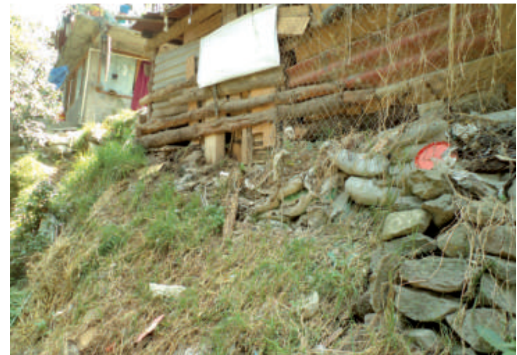
Figura 5.86. Fotografía C de vulnerabilidad en Buenavista. Vivienda precaria desplantada sobre un talud de material deleznable (19,2957° N, 99,2540° W. Calle: Cañada).
