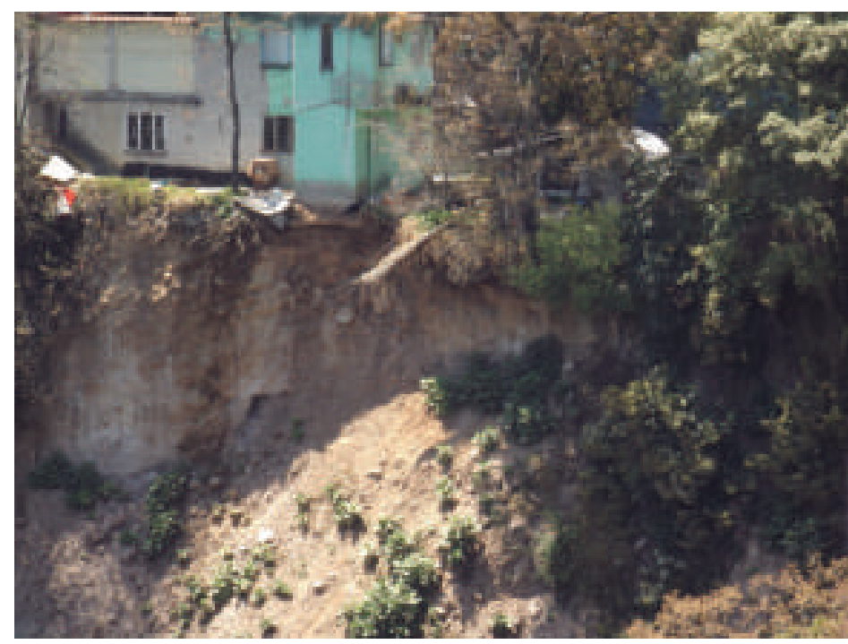
Figura 5.5. Fotografía A del polígono de peligro San José de los Cedros. Derrumbe ocurrido el 5 septiembre del 2014, en donde la vivienda en color verde presenta inclinación en dirección hacia la barranca y pérdida de material en su basamento. La vivienda fue deshabitada después de ocurrido el fenómeno (19.3748° N, 99.2907° W. Calle: Prolongación Ocote).
