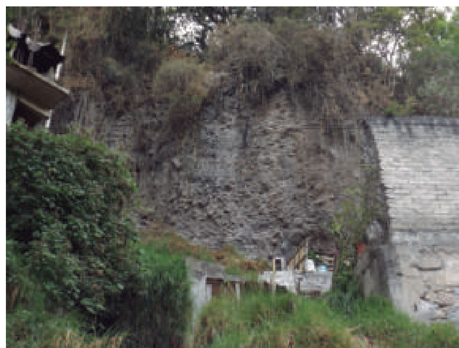
Figura 5.13. Fotografía A del polígono e peligro 25 de Diciembre. Construcción precaria ubicada al pie de un talud de 7 m de alto aproximadamente, compuesto de flujos de bloques y cenizas, los cuales son altamente deleznales (19.3813° N, 99.2818° W. Calle: sin nombre oficial).
