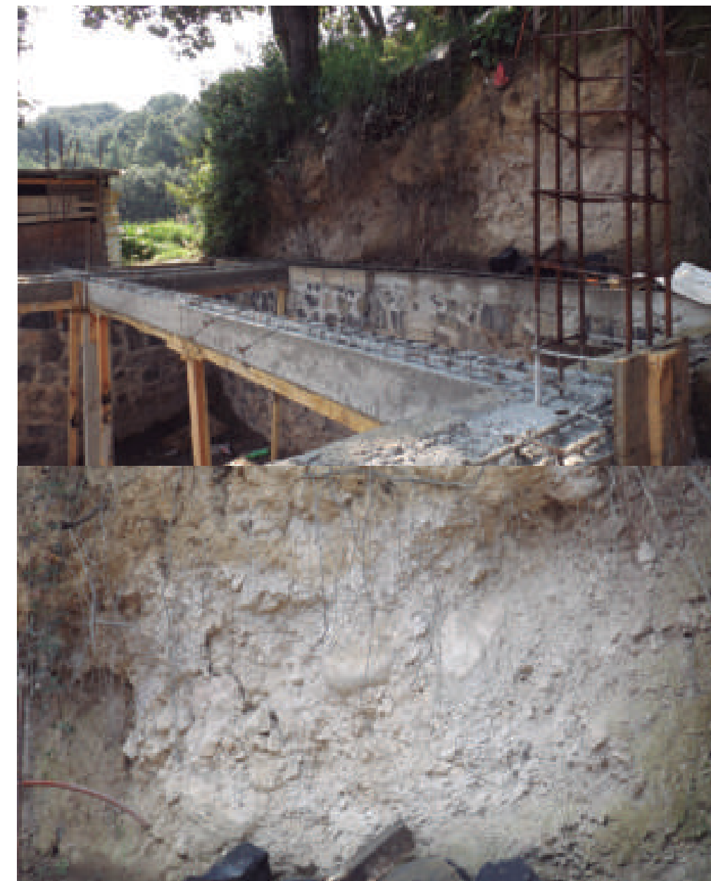
Figura 5.152. Fotografía B del polígono de peligro Valle Conejos. Corte hecho en el talud con fines constructivos; dicho talud no tiene algún tipo de cubierta que lo proteja de la erosión. En la fotografía de abajo se observa la composición litológica del mismo, que consiste en materiales inestables como cenizas y bloques de hasta 30 cm en el eje mayor (19.3397° N, 99.2894° W. Calle: sin nombre oficial).
