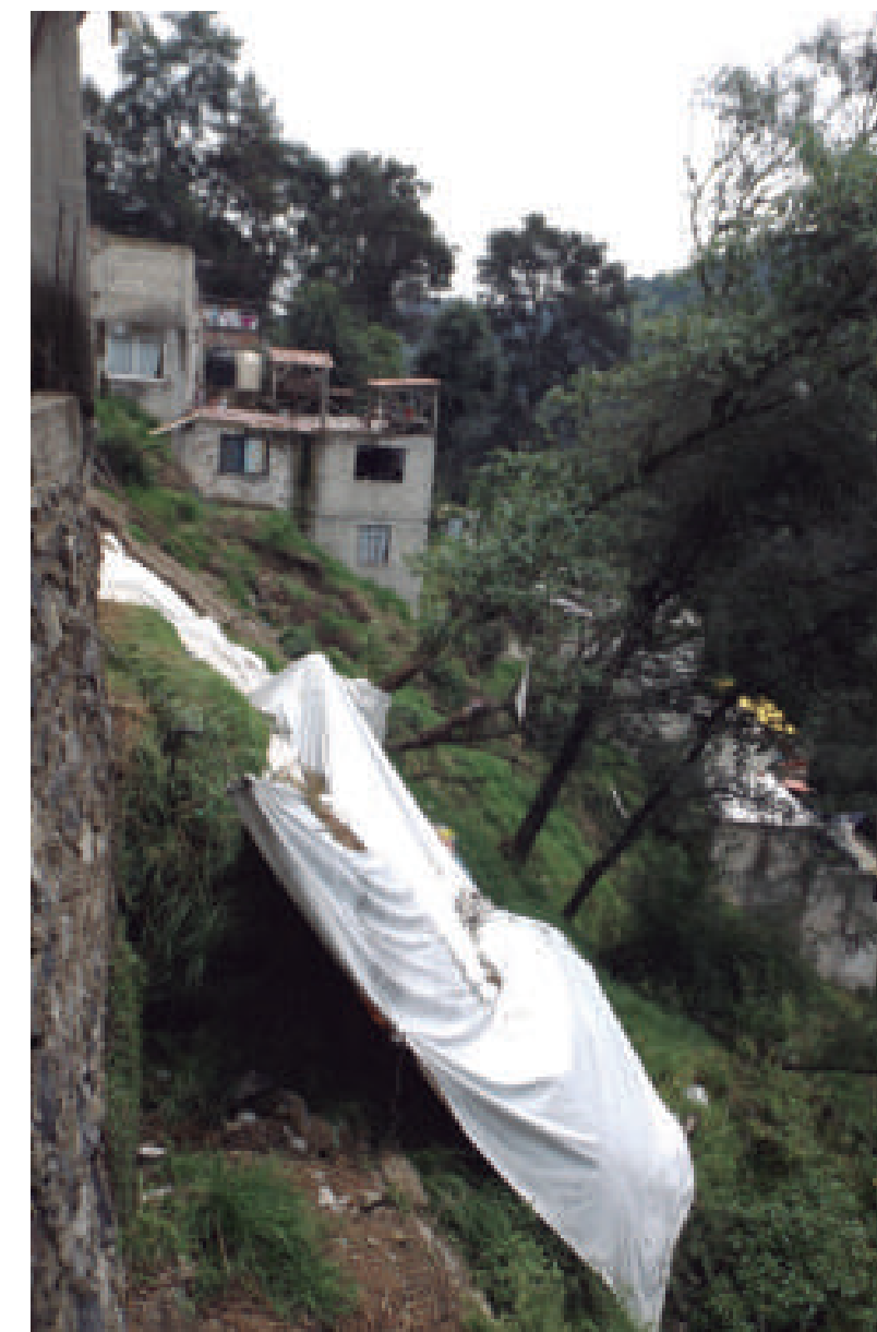
Figura 5.85. Fotografía B del polígono de peligro San Pablo Chimalpa. Superficie de erosión cubierta con una lona de plástico para evitar el desgaste y la consecuente remoción de los materiales; sobre el talud se encuentran algunas construcciones. Se observan árboles inclinados, lo cual indica que existe movimiento en la ladera (19.3572° N, 99.3119° W. Calle: sin nombre oficial).
