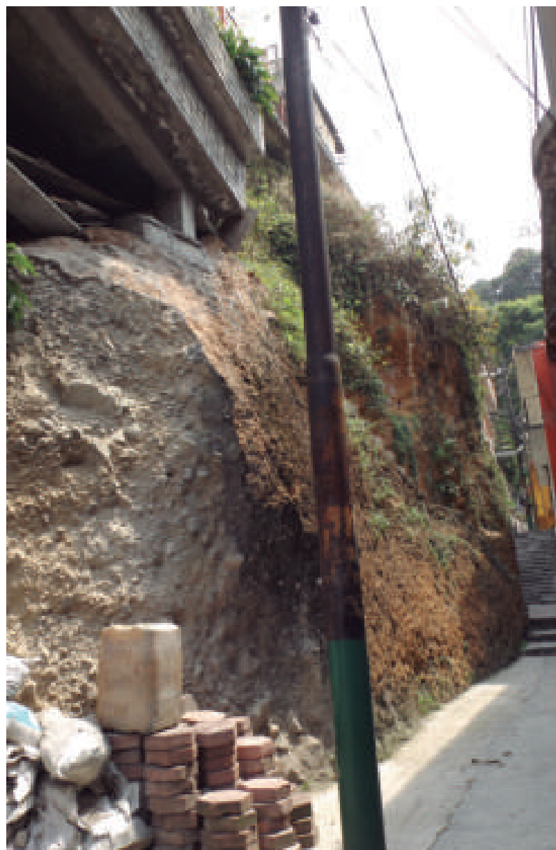
Figura 5.48. Fotografía C del polígono de peligro Tamarindos. Afloramiento de flujo de bloques y cenizas, sobre el cual se asienta una construcción sostenida por pilares delgados de concreto reforzado; dicho talud estaba cubierto por concreto lanzado, sin embargo parte del recubrimiento ha colapsado, dejando expuestos a los materiales (19.3841° N, 99.2557° W. Calle: 3er Andador).
