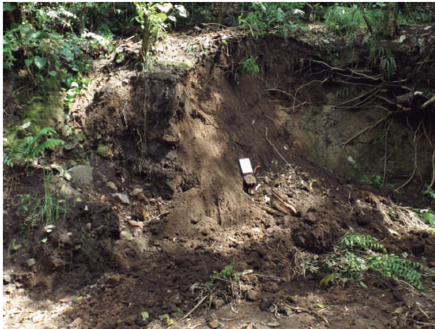
Corona de un deslizamiento rotacional en Acopilco.
