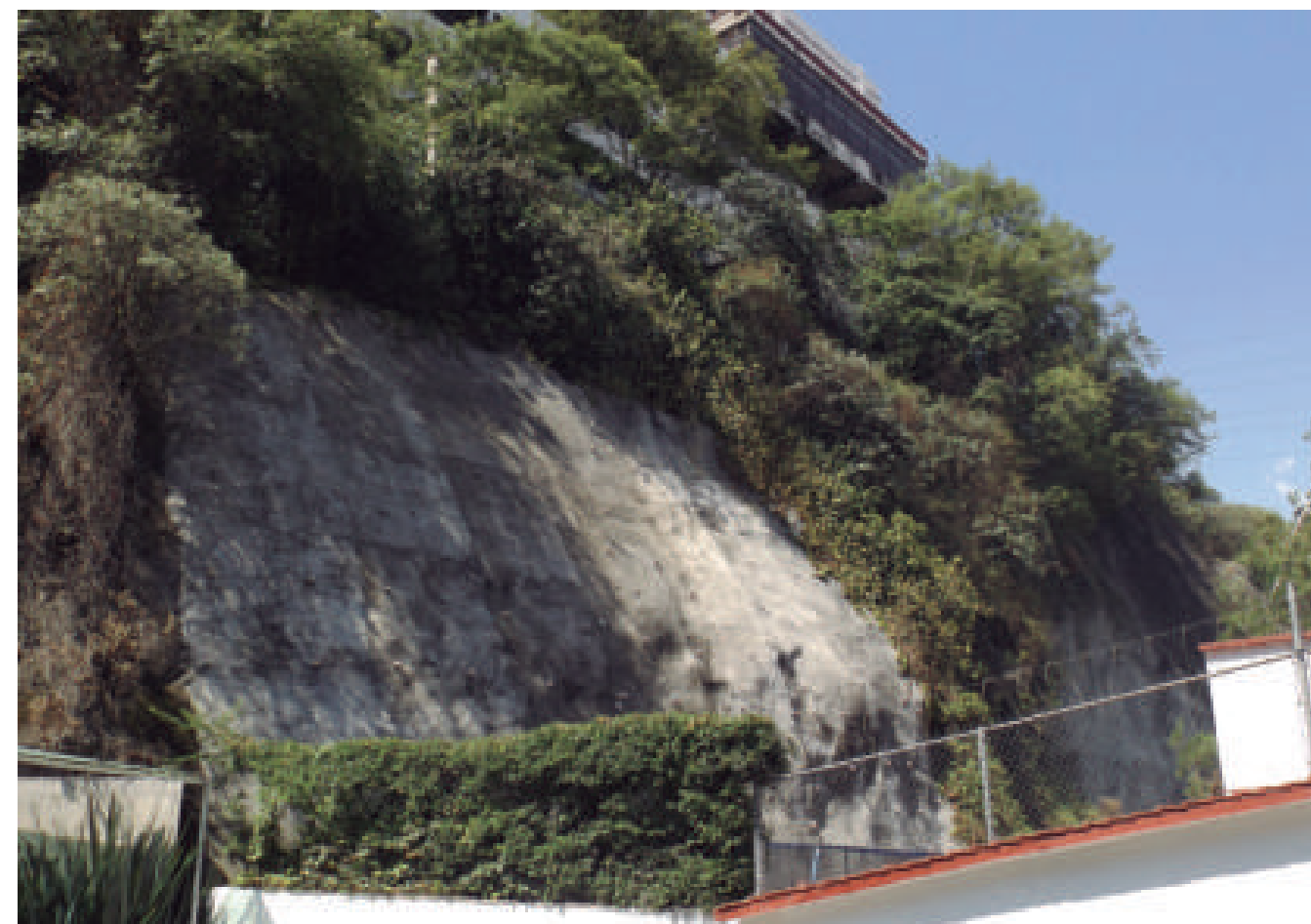
Figura 5.31. Fotografía B del polígono de peligro Pegaso.
