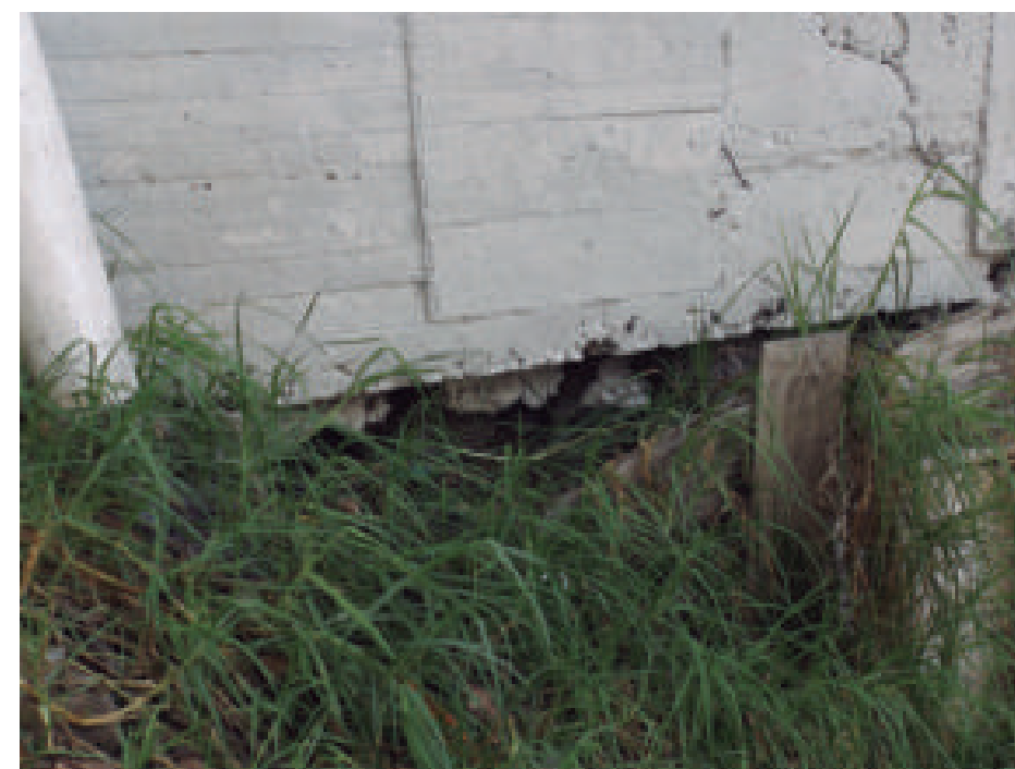
Figura 5.26. Fotografía A de la imagen 3 de vulnerabilidad del polígono Hueyatlaco. Vivienda en la orilla de la barranca que presenta pérdida de material en el basamento debido a la erosión y al flujo del drenaje de la misma. A su vez se puede observar hacia la derecha de la fotografía un árbol inclinado, evidencia de la inestabilidad del terreno (19.3705° N, 99.2833° W. Calle: Campanitas).
