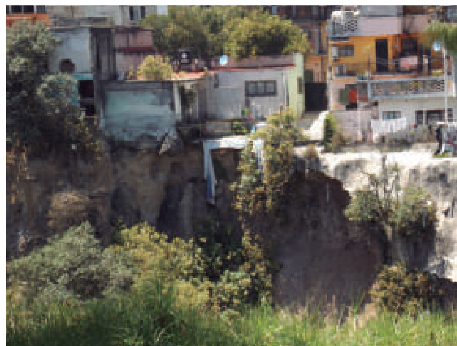
Figura 5.9. Fotografía A de la imagen 1 de vulnerabilidad del polígono San José de los Cedros. Pérdida parcial del concreto lanzado debido a colapsos y derrumbes de los materiales de la barranca que ponen en riesgo las viviendas asentadas en la parte superior, las cuales presentan pérdida de basamento y se encuentran altamente vulnerables (19.3743° N, 99.2892° W. Calle: Prolongación Ocote).
