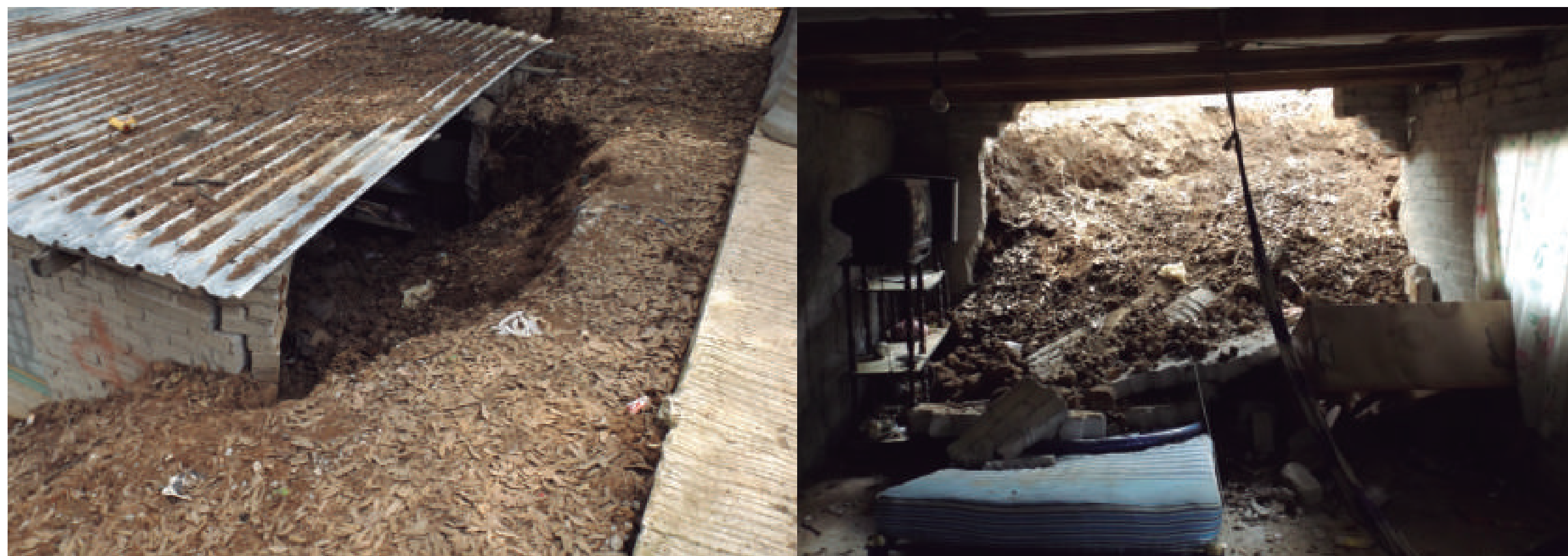
Figura 5.82. Fotografía C de la imagen 9 de vulnerabilidad del polígono 16 de Septiembre.
