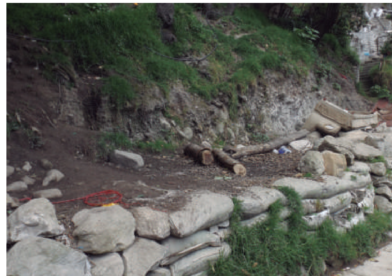
Figura 5.19. Fotografía C de la imagen 2 de vulnerabilidad del polígono 25 de Diciembre. Rocas y costales rellenos apilados con el fin de detener los materiales volcánicos que componen al talud (19.3812° N, 99.2815° W. Calle: sin nombre oficial).
