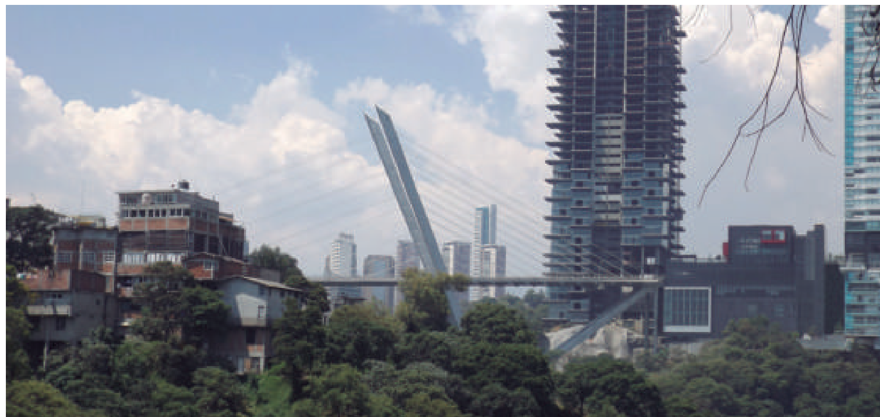
Obras viales en construcción en Santa Fe, donde el clima es templado subhúmedo.
