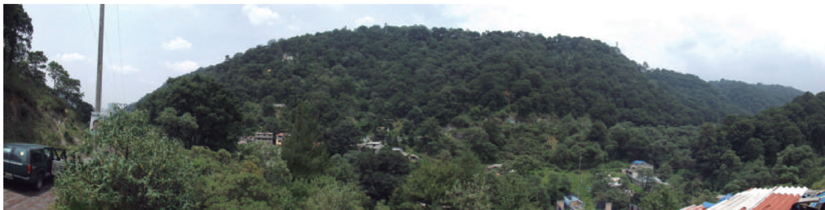
Figura 5.66. Fotografía A del polígono de peligro Ahuatenco. Ladera sobre la que se asientan el polígono de peligro y el sitio con riesgo Paraje Ahuatenco (SPC, 2014), cuya altura es de 800 m (19.3674° N, 99.3108° W. Calle: sin nombre oficial).
