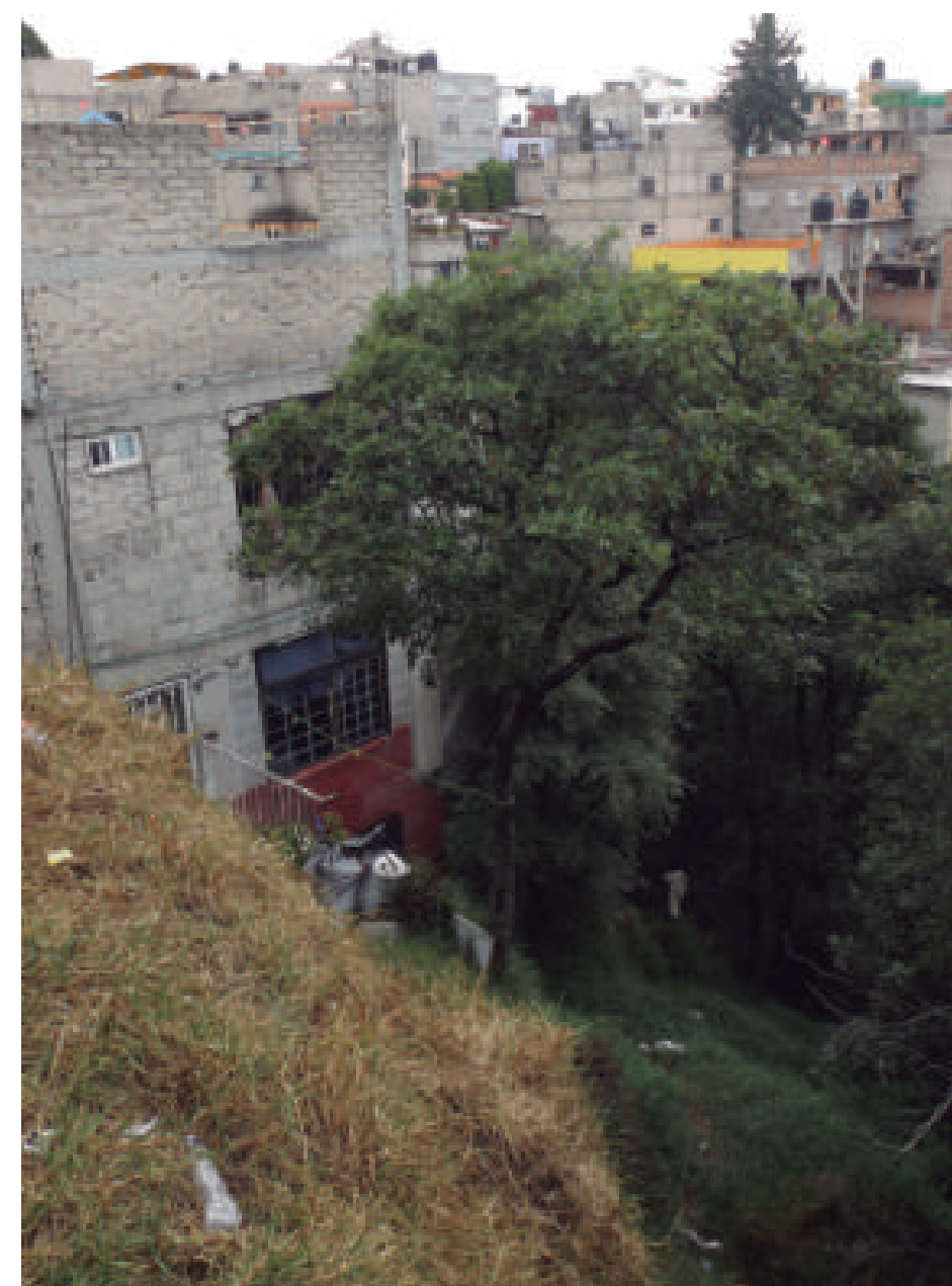
Figura 5.17. Fotografía A de la imagen 2 de vulnerabilidad del polígono 25 de Diciembre. Vivienda construida en uno de los flancos de la barranca, el cual está cubierto de vegetación; al centro se distingue un árbol que presenta inclinación en dirección a la pendiente (19.3811° N, 99.2824° W. Calle: Cerrada 25 de Diciembre).
