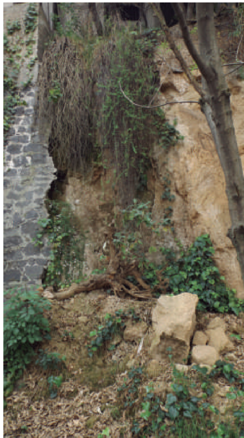
Figura 5.42. Fotografía B de la imagen 5 de vulnerabilidad del polígono Tejocotes. Parte de un muro de mampostería que colapsó parcialmente debido a la inestabilidad de los materiales del talud que cubría; al pie del mismo se aprecia el depósito de los materiales que han caído por la pendiente (19.3875° N, 99.2568° W. Calle: Bosque de Helechos).
