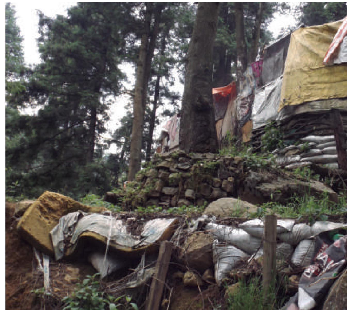
Figura 5.133. Fotografía D de la imagen 15 de vulnerabilidad del polígono Las Lajas. Muro de contención elaborado con costales apilados rellenos de material de sitio, rocas y diversos materiales de bajo costo. En la cima se observa la barda perimetral de una vivienda (19.3102° N, 99.3331° W. Calle: sin nombre oficial).
