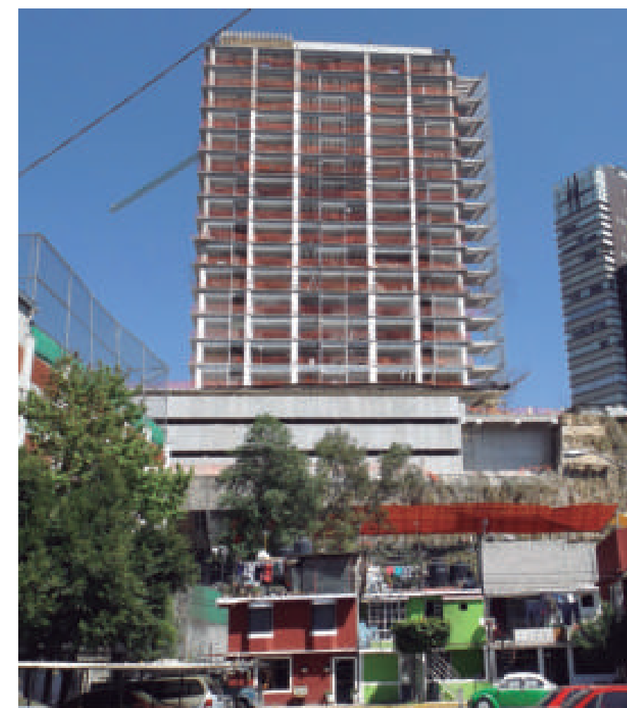
Edificios en construcción sobre la avenida Vasco de Quiroga, Santa Fe.
