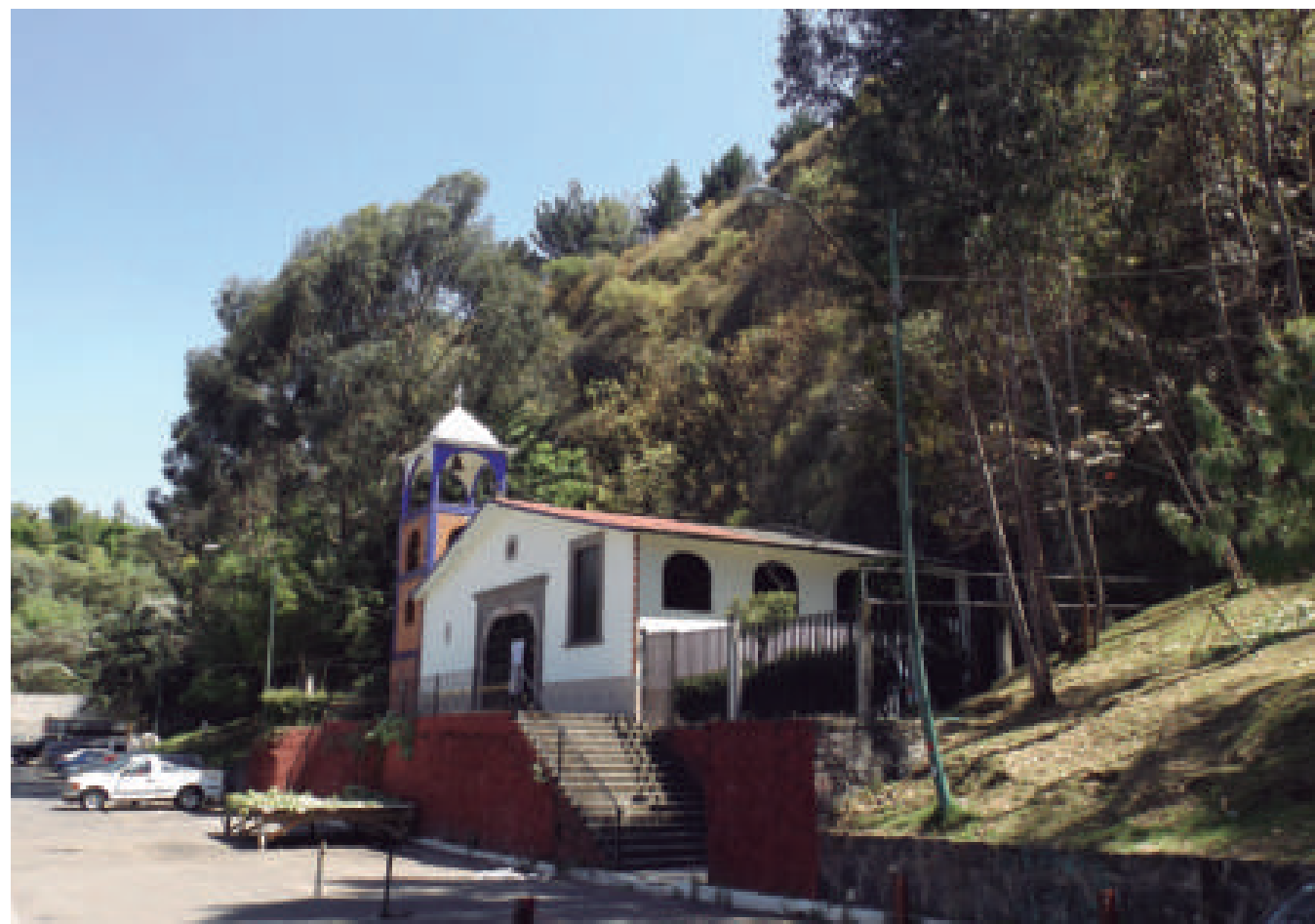
Figura 5.27. Fotografía B de la imagen 3 de vulnerabilidad del polígono Hueyatlaco. Iglesia construida al pie del talud parcialmente cubierto de vegetación; en la parte alta hay bloques expuestos (de aproximadamente 1.5 m en el eje mayor) que pueden sufrir caídas y causar daños en la estructura del inmueble (19.3687° N, 99.2813° W. Calle: Huiz-aa).
