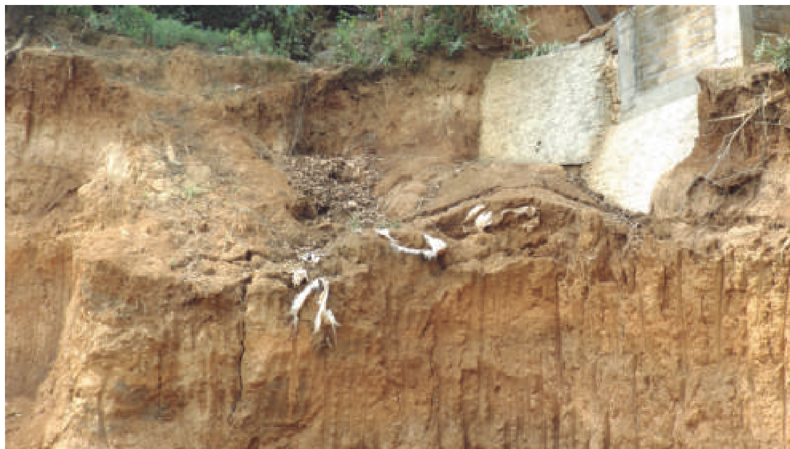
Talud donde se observan los diferentes horizontes del suelo en la colonia Ahuatenco.
