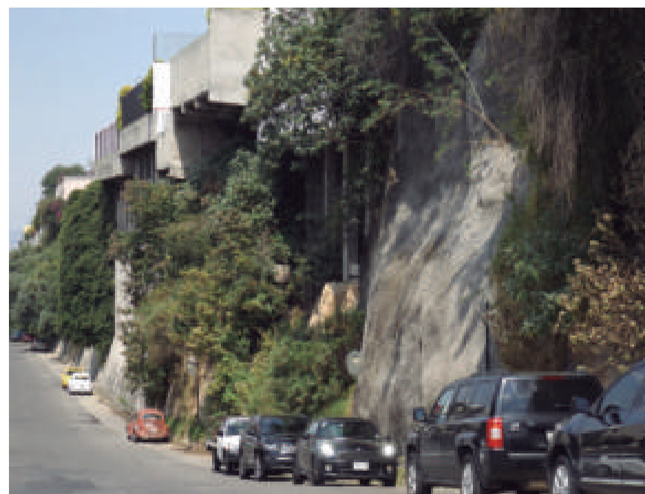
Figura 5.41. Fotografía A de la imagen 5 de vulnerabilidad del polígono Tejocotes. Porción de la ladera con recubrimiento de concreto lanzado y otra con vegetación, cuya pendiente es cercana a los 90°; sobre la misma se aprecian algunas construcciones (19.3839° N, 99.2612° W. Calle: Bosque de Tejocotes).
