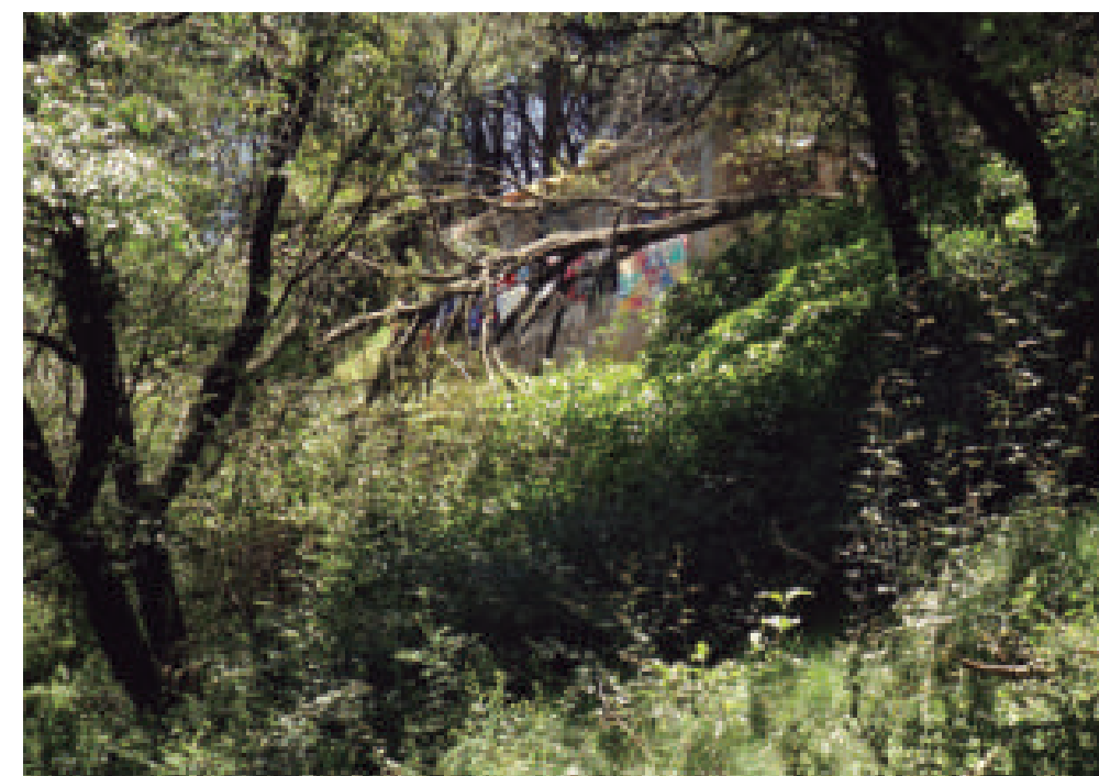
Figura 5.104. Fotografía C del polígono de peligro Texcalco. Árboles inclinados en dirección favorable a la pendiente; esto constituye un indicio de la actividad de los procesos de remoción en masa que afectan a la ladera y que ponen en vulnerabilidad alta a las viviendas (19.3291° N, 99.3312° W. Calle: sin nombre oficial).
