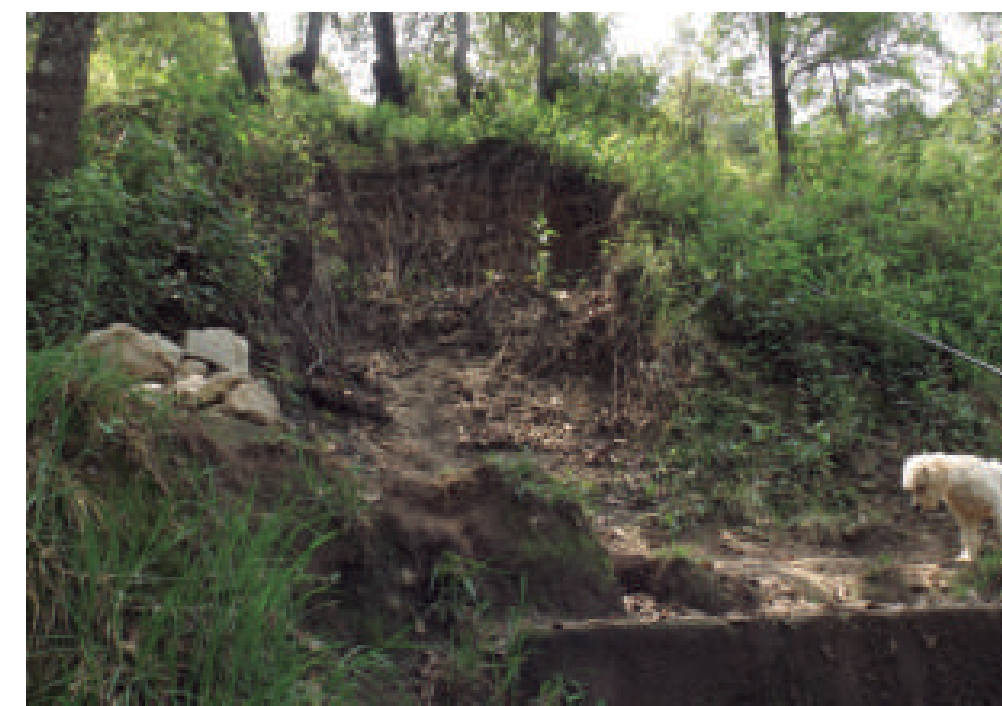
Figura 5.69. Fotografía D del polígono de peligro Santa Rosa. Viviendas construidas con material precario asentadas a lo largo de la ladera cubierta en su mayoría por vegetación; al fondo se puede apreciar la elaboración de terrazas en la ladera para desplantar las construcciones, dando como resultado cortes verticales donde el material es erosionado con mayor facilidad (19.3240° N, 99.2954° W. Calle: sin nombre oficial).
