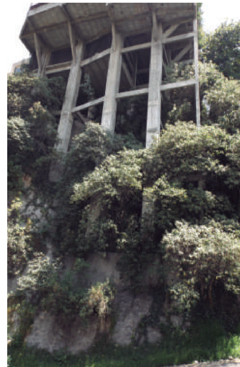
Figura 5.49. Fotografía D de polígono de peligro Tamarindos. Talud de aproximadamente 20 m de alto con presencia de vegetación. Sobre éste se asienta una construcción con un volado sostenida por pilotes de concreto reforzado y muros transversales de mampostería (19.3929° N, 99.2486° W. Calle: Bosque de Guanábanos).
