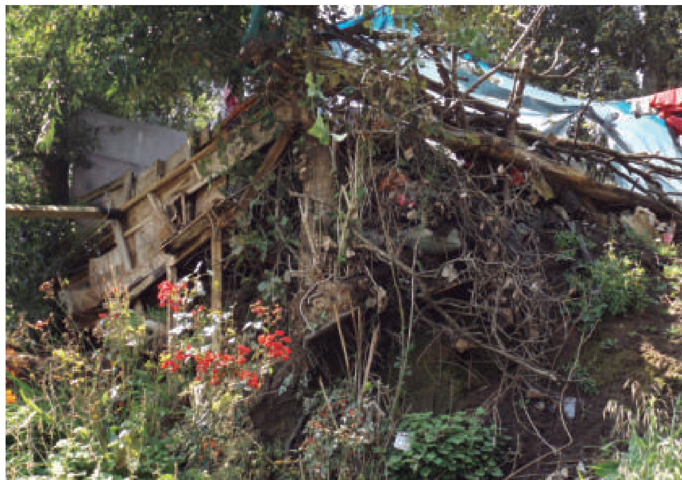
Figura 5.157. Fotografía B de la imagen 18 de vulnerabilidad del polígono Valle Conejos. Vivienda precaria desplantada sobre un talud que se sostiene sobre árboles inclinados y diversos materiales que constituye la barda perimetral, la cual tiene una inclinación favorable a la pendiente; el basamento está relleno con rocas apiladas (19.3397° N, 99.2892° W. Calle: sin nombre oficial).
