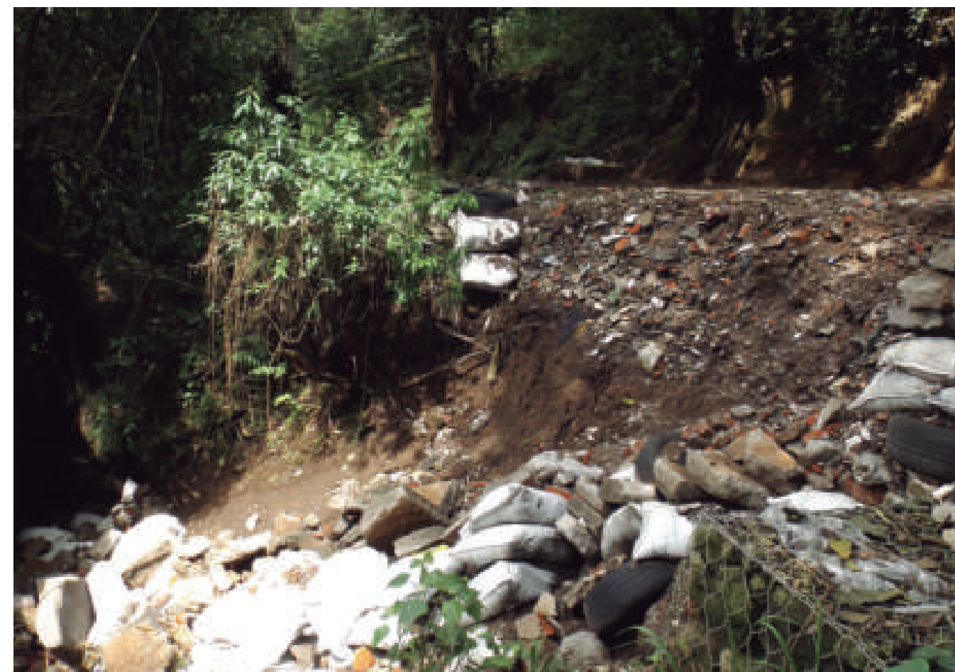
Figura 5.96. Fotografía C del polígono de peligro Acopilco. Cicatriz de derrumbe ocurrido en uno de los flancos de la barranca, donde se observa el uso de costales rellenos de materiales de sitio como medida de contención para evitar que siga en movimiento; sin embargo, en la parte baja de la fotografía se observa que algunos de los costales han caído en dirección a la pendiente 19.3344° N, 99.3255° W. Calle: sin nombre oficial).
