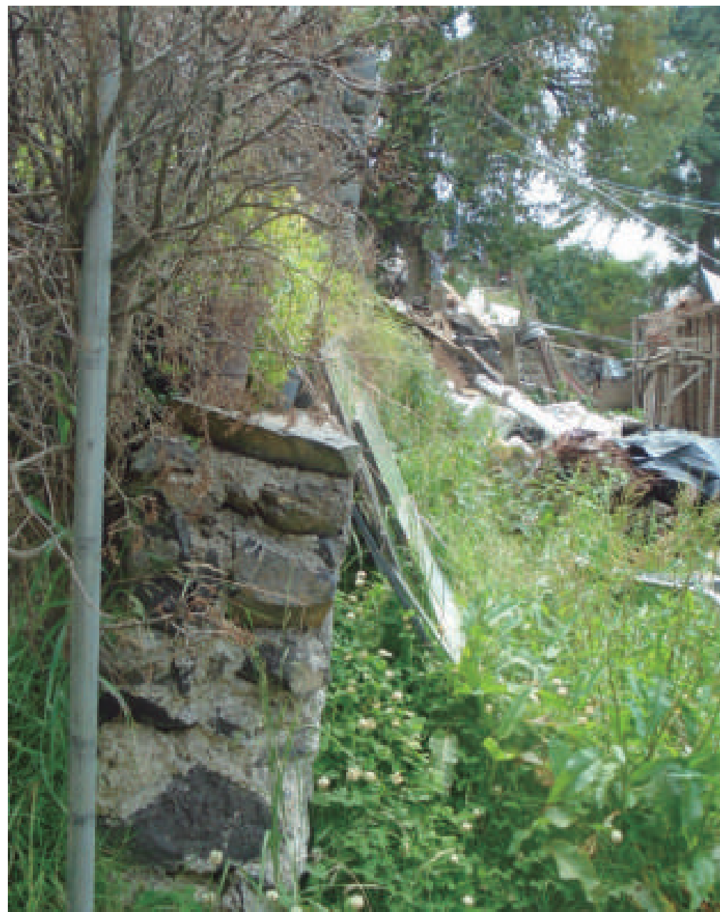
Figura 5.114. Fotografía B de la imagen 13 de vulnerabilidad del polígono Cruz Blanca. Muro de mampostería con mortero que presenta inclinación en favor de la pendiente, debido a que el material que usa como basamento es inestable y presenta movimiento lento, por lo cual la estructura va perdiendo verticalidad (19.3229° N, 99.3233° W. Calle: sin nombre oficial).
