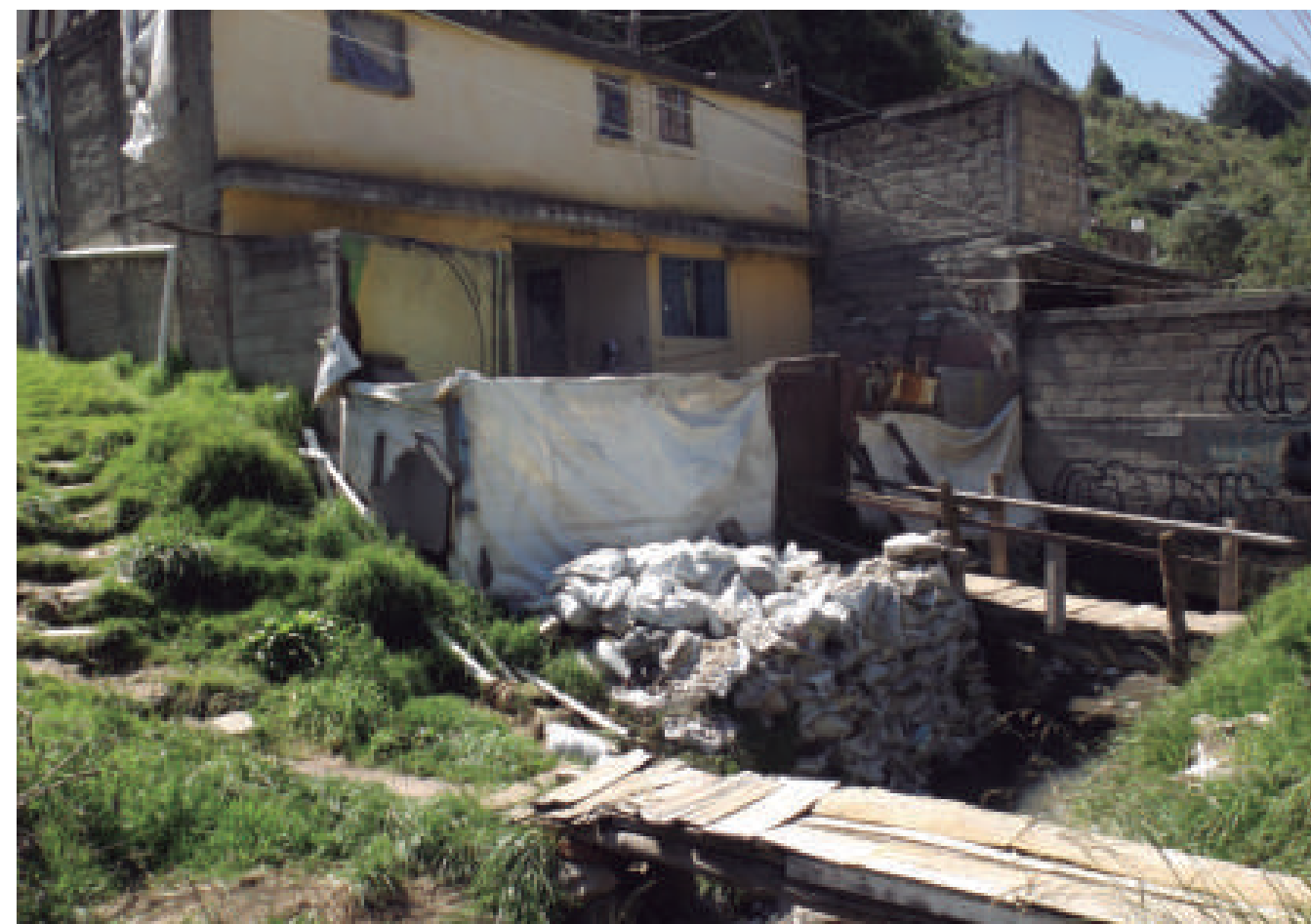
Figura 5.122. Fotografía B de la imagen 14 de vulnerabilidad del polígono San Bernabé. Viviendas ubicadas en la orilla de un cauce; al centro de la fotografía se observan algunos costales rellenos, apilados con el fin de evitar la erosión del material que utiliza la vivienda como basamento (19.3137° N, 99.3379° W. Calle: Camino a San Bernabé).
