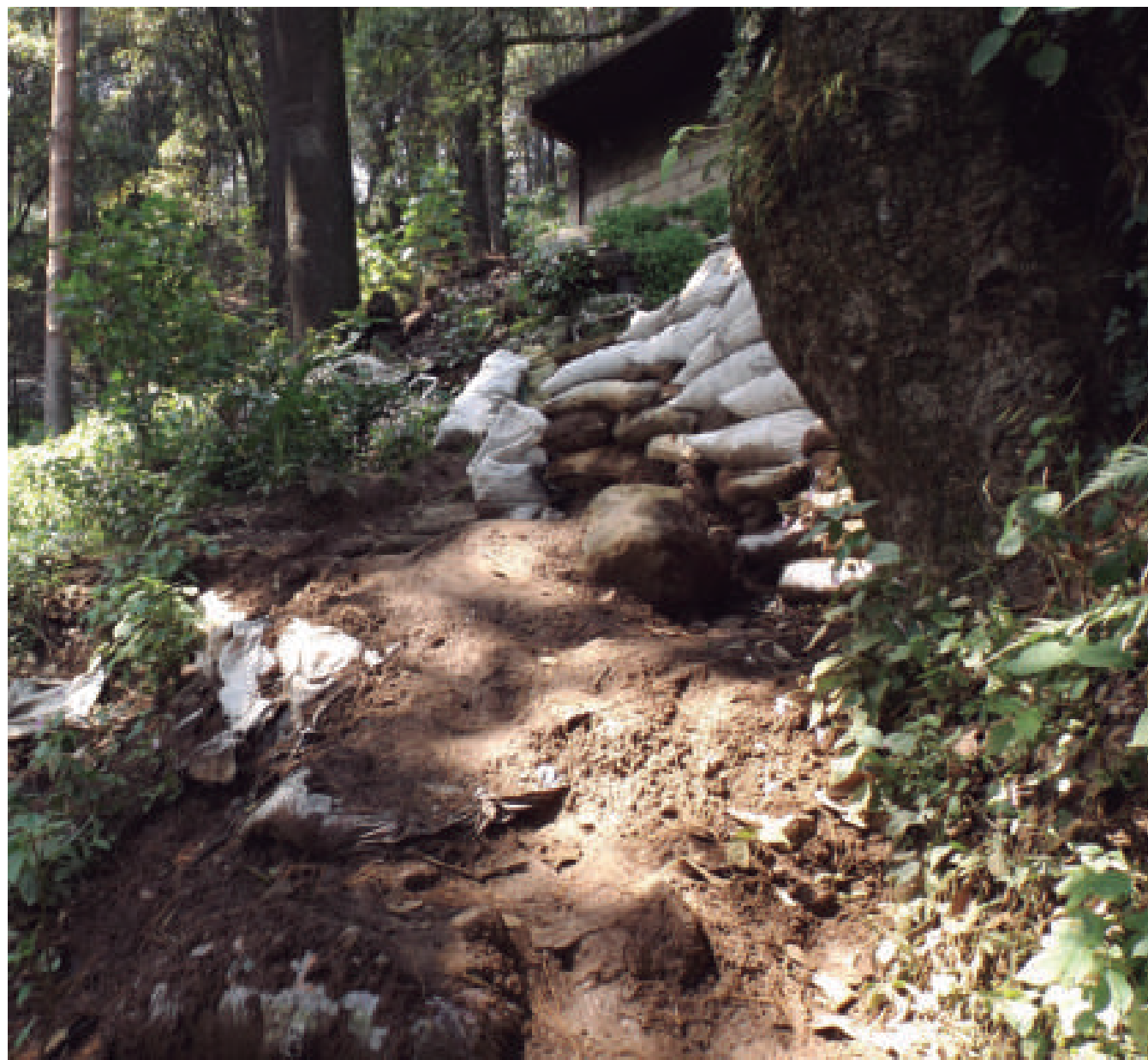
Figura 5.151. Fotografía A del polígono de peligro Valle Conejos. Parte de un talud inestable cuyos materiales están sobresaturados por lluvias abundantes. Hacia arriba se distinguen una serie de costales rellenos apilados con el fin de detener el material; algunos de ellos se hallan en avanzado estado de deterioro y han caído por la pendiente. En la parte superior del talud se observa una construcción (19.3392° N, 99.2900° W. Calle: sin nombre oficial).
