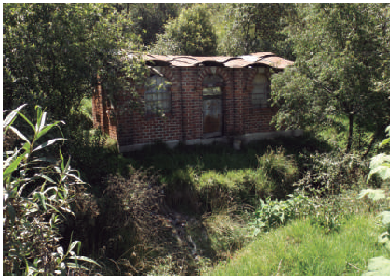
Figura 5.116. Fotografía A del polígono de peligro San Bernabé.
